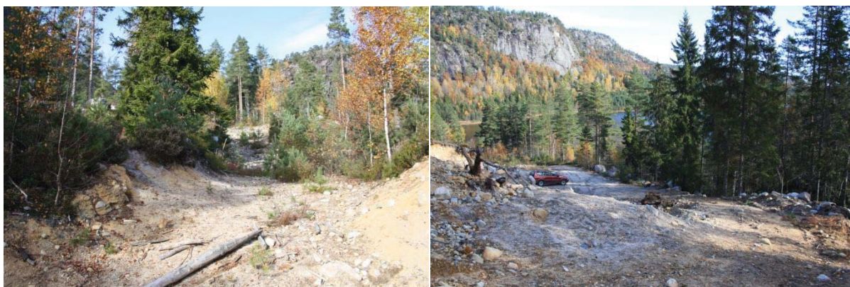
Figur 8: Bildene viser starten på traktorslepe (venstre) fra skogsbilvei og sandtak (høyre) nede ved kraftstasjonsområdet. Skålbuvatnet skimtes bak furuskogen (høyre).
