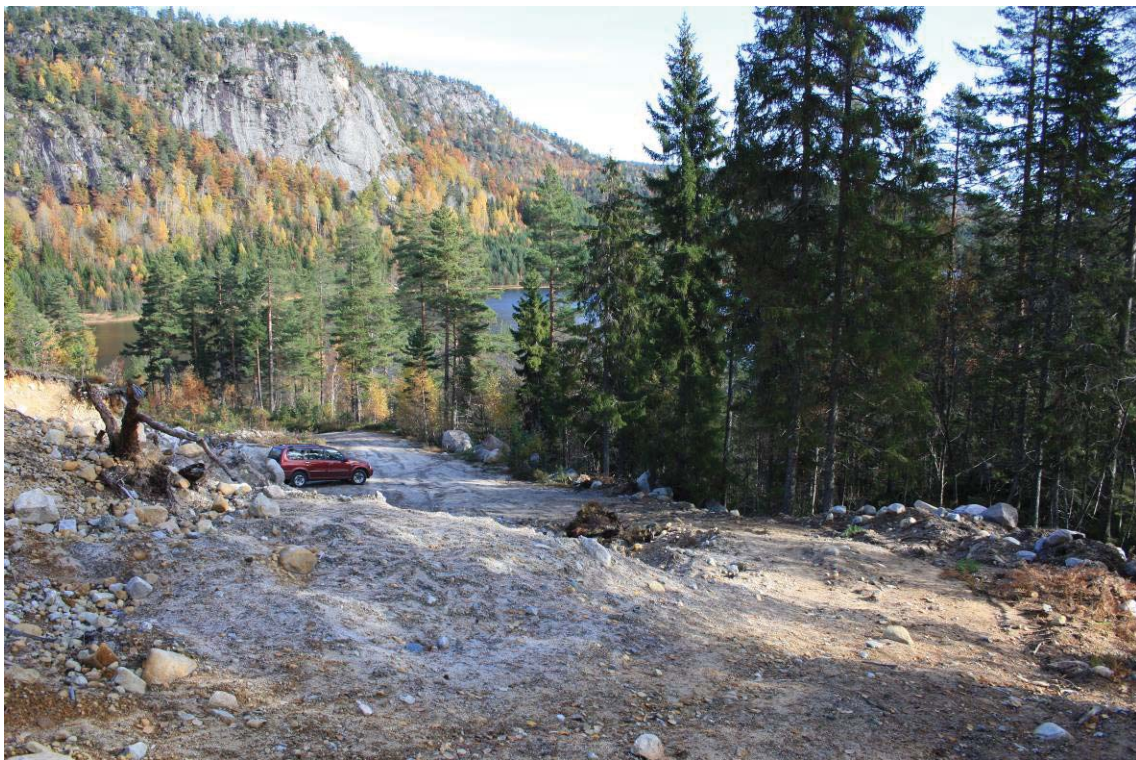
Bilde fra sandtaket like ved kraftstasjonsområdet
