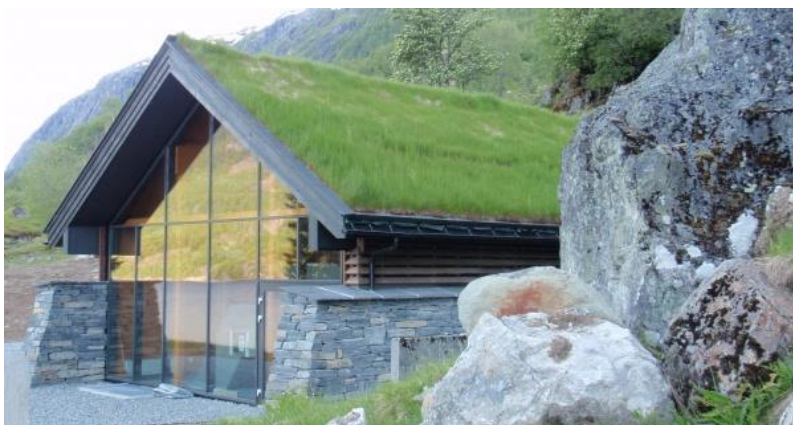
Bilde: Typisk Kraftverksbygning
