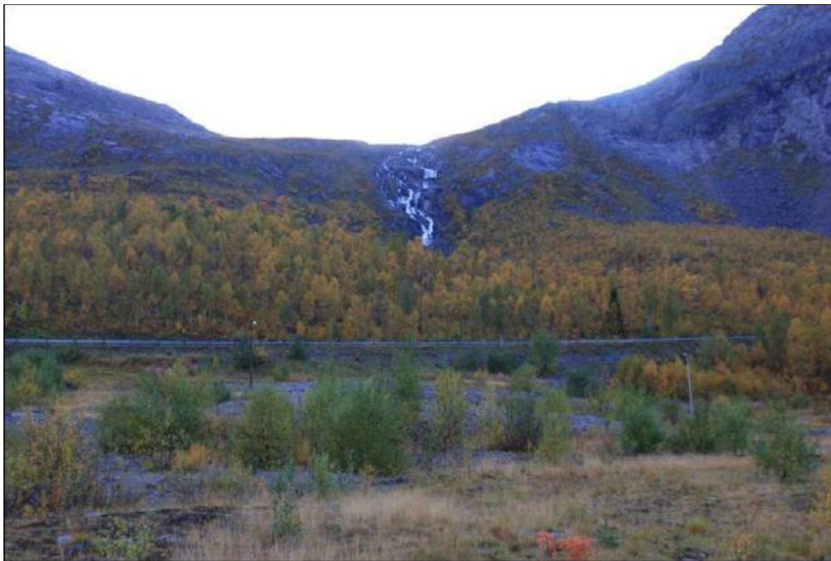
Figur 1: Kobbskarelva sett i fra Lysløyppa. Nedgravd rørgate vil følge høyre side av elven opp til bart fjell. Her vil det etableres et tunnelpåhugg og vannveien vil gå i tunnel opp til inntaket. Kraftstasjonen vil etableres på høyre side av elven, ovenfor E6.
