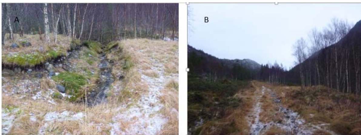
Figur 10 A -Morenemateriale ved bekk ved pr 1400. B – Bilde tatt mot nordøst langs traséen og viser tynt løsmassedekke langs eksisterende skogsveg.
