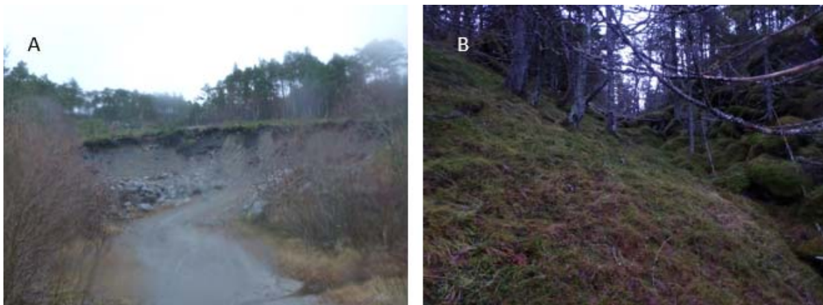
Figur 17 A – Løsmasser ved eksisterende veg like øst for pr ca. 200. B – Urmasser i søkk i terreng ved pr 950.
