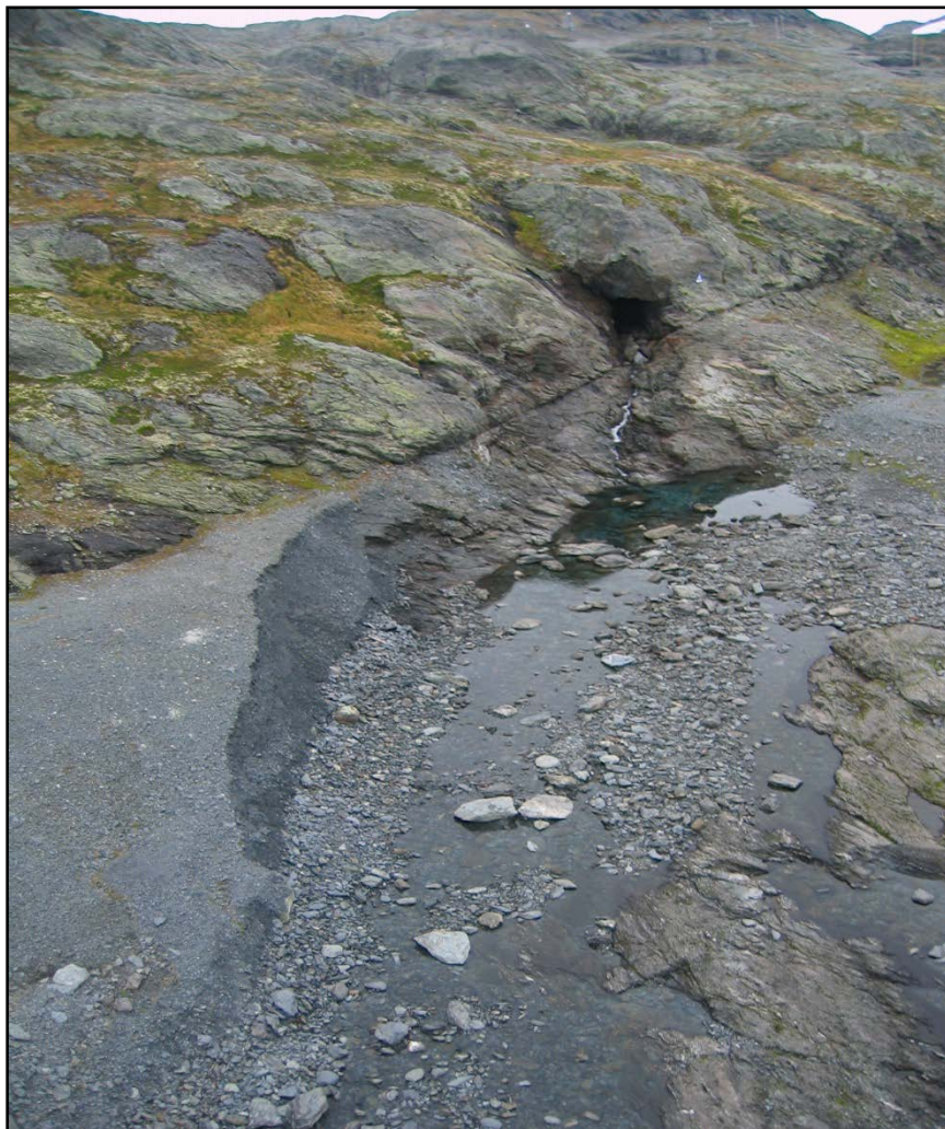
Figur 2.2 Utløpet av overføringstunnelen fra Øvre Tyssevatnet
