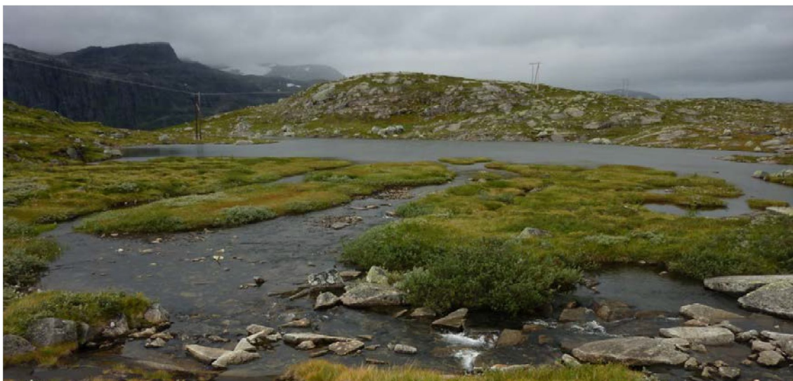
Figur 10. Kraftledning ved tjern 1051 på Floren.
