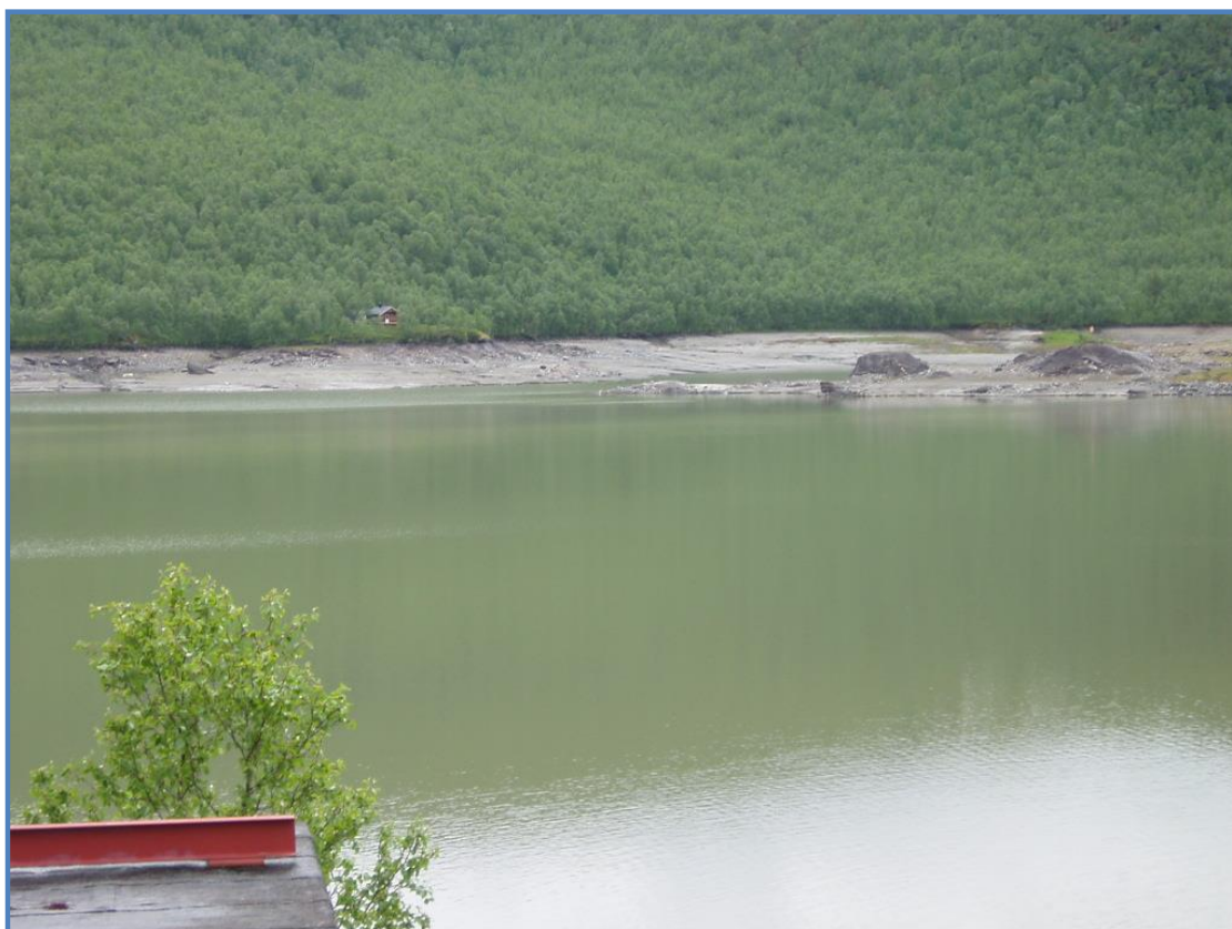
Hjertvatnet tappet ned 9,03 m i forbindelse med revisjon av luker. Foto: BEAS.
