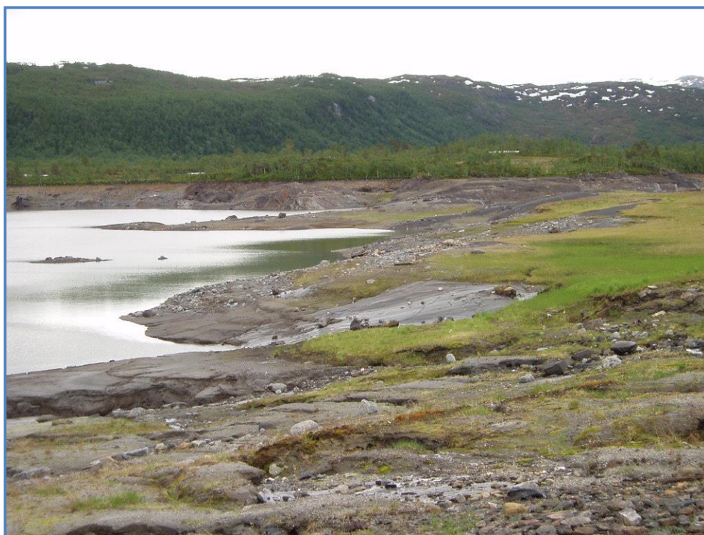
Figur 2.3: Avsnitt av magasin Hjertvatn regulert svært langt ned i forbindelse med rehabilitering. Foto: BEAS.
