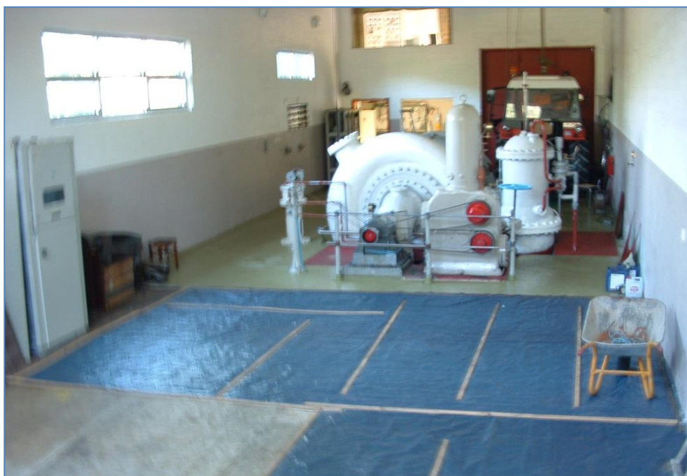
Figur 4.6: Bildet viser hvor det nye aggregatet vil bli plassert
