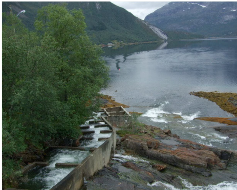
Forsaforsen og laksetrappen over det siste strekket mot Forsahavet. Trappen ble bygd i 1984, og er årsak til at Forsavaddraget er lakseførende i dag. Foto: Morten W. Melby.
