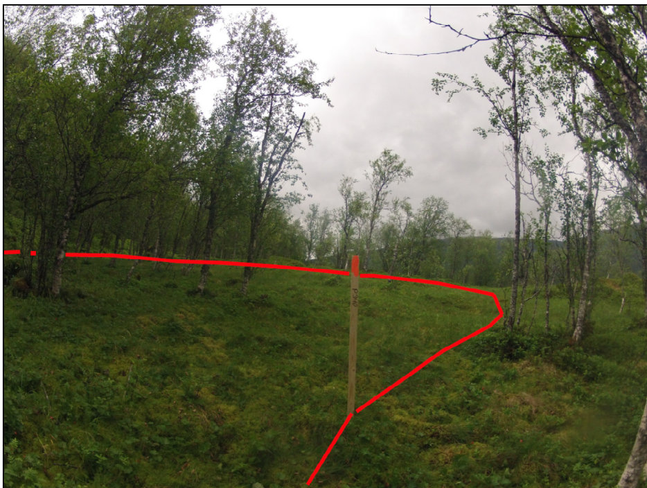
Bilde 19. For å unngå store skjæringer og fyllinger er svinger på anleggsvegen forsøkt lagt på så flate områder som mulig. Dette bildet er fra P 340. Her er det en 180 graders sving for anleggsvegen går diagonalt oppover lisen mot Lillevatnet.
