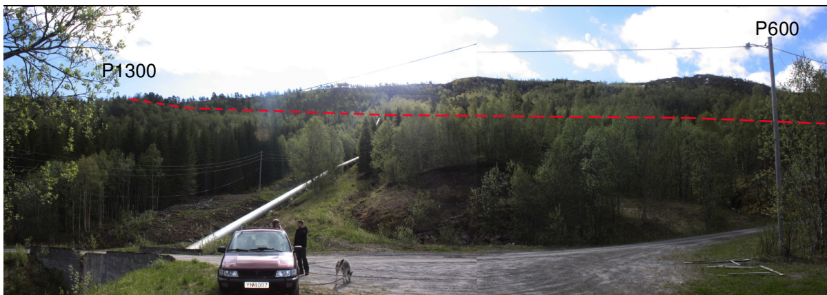
Bilde 17. Bildet er tatt mot øst fra parkeringsplassen/ eksisterende veg ved Kraftstasjonen ved Sjurvatnet. Den stiplede røde streken illustrere hvordan den planlagte anleggsveggen går diagonalt fra sørvest mot nordøst i lisen øst for Sjurvatnet. Grunnen til at den er stiplet er at vegen vil i all hovedsak være skjult pga den relativt tette vegetasjonen i lisen. Vegen er også lagt slik at den følger naturlige platåer/ flater i lisen slik at man unngår unødvendige store fyllinger og skjæringer.
