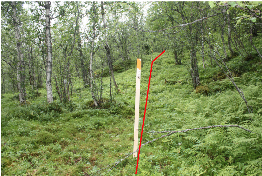
Bilde 20. Bildet er tatt ved P 540 og viser et område hvor anleggsvegen følger en naturlig "hylle" i terrenget. Vegen er planlagt slik at man i størst mulig grad følger terrenget slik at man unngår at det må anlegges store fyllinger eller skjæringer.
