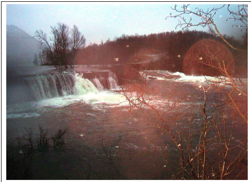
Figur 3.6.b : Overtopping av vegfylling/dam langs Sjurvatnet under storflom i januar 2002. Vannføringen er ca 50 m 3 /s. Foto Wiggo Knutsen, Ballangen Energi.
