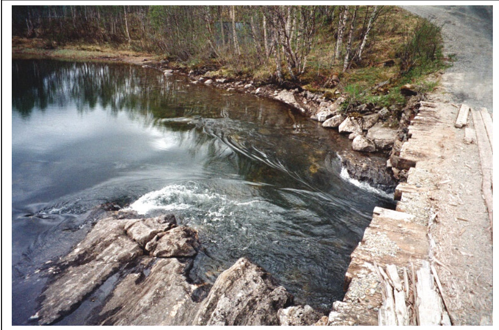
Figur 5.6.c: Bestemmende profil i utløpet av Sjurvatn 10. juni 2001. Vannføring ca 4 m 3 /s. Se også figur 3.6.b side 29, vannstanden i Sjurvatnet er da ca 1 m høyere og i nivå med veibrua.
