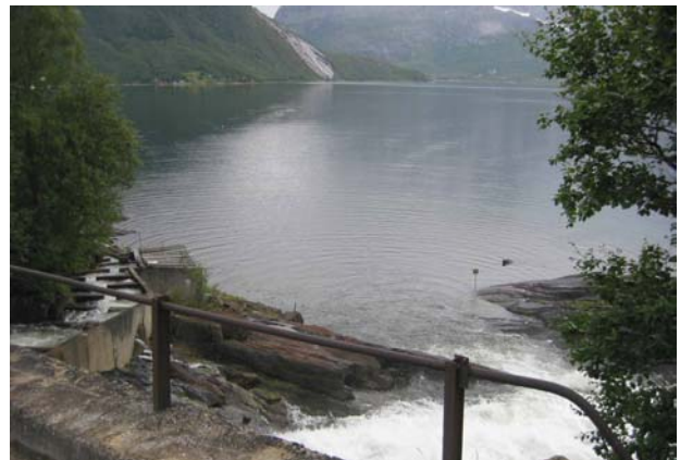
Nedre del av laksetrappa i Forsåelva (venstre i bildet)
