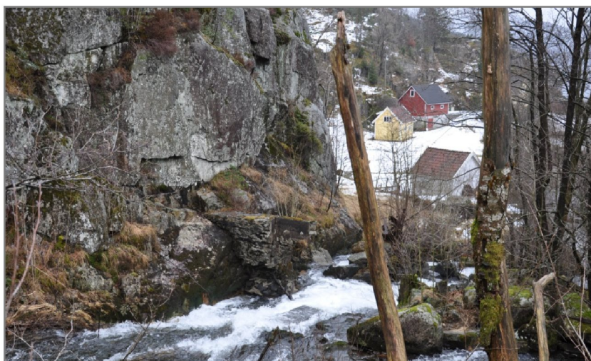
Figur 33: Restar av damkonstruksjon til kraftanlegg. Kraftstasjon er det kvite huset i bakgrunn av bildet.
