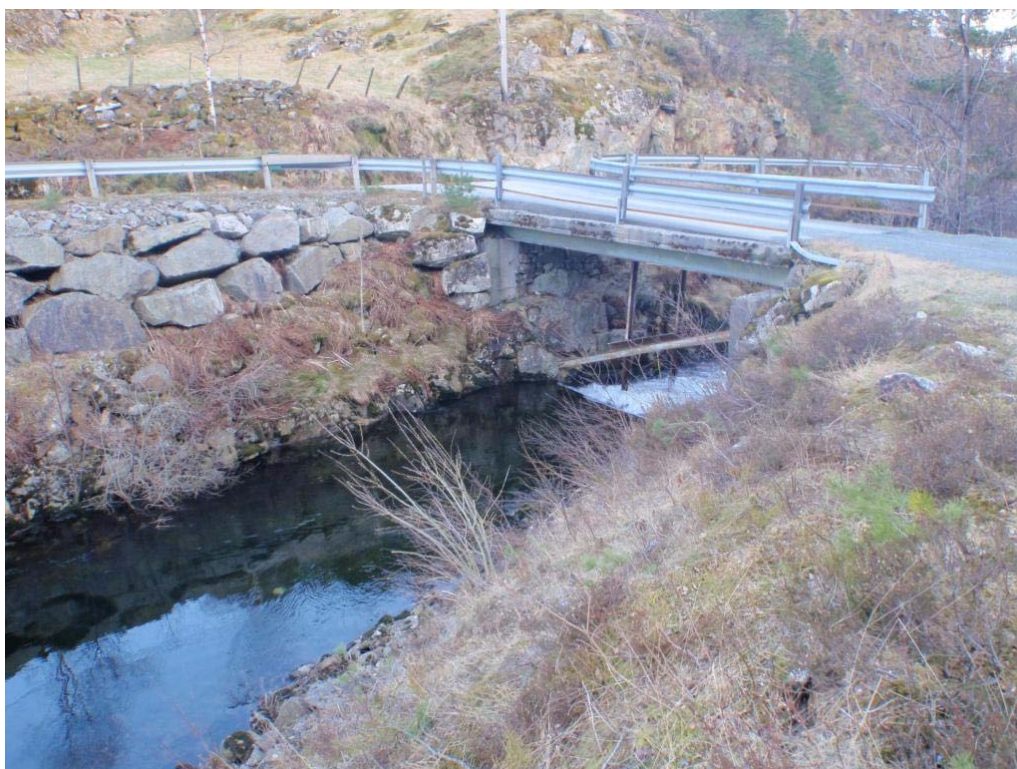
Figur 5: Bro over utløpsos, sett fra vestre side
