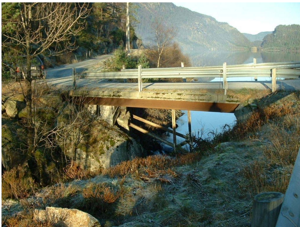
Figur 4: Bro over utløpsos, sett fra austre side og innover Grytevatnet
