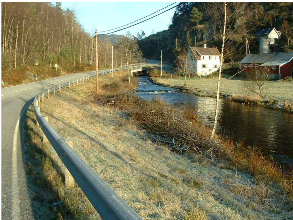
Figur 9: Fylkesveg bru og bolighus, sett frå nedstrømsside. Høgde frå elvekant til grunnmur er mellom 0,5 og 1m.
