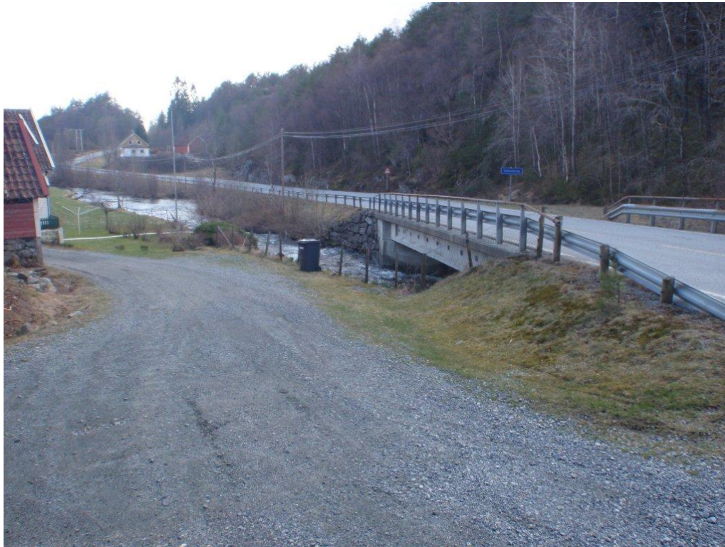
Figur 6: Bru fylkesveg, Lysopning på bru er ca 1-1,5m og breidda av bru er ca 7 m. Bildet er tatt dag med relativ høg vassføring
