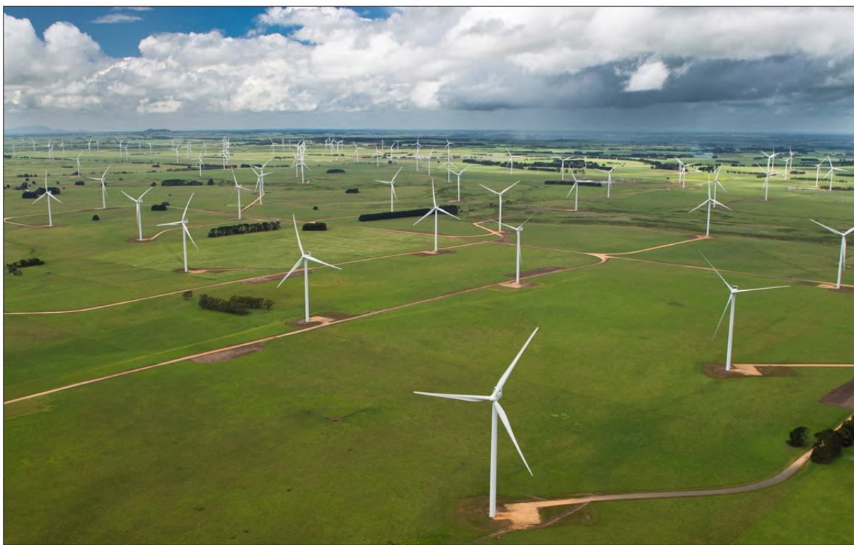
Figur 2. Vestas V112 turbiner i et australsk landskap. Et internt nettverk av veger og jordkabler legges mellom turbinene og trafo/driftsbygning sentralt i planområdet. Kilde: Vestas.
