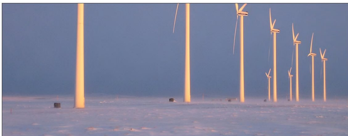
Figur 100. Iskast fra rotorbladene utgjør en potensiell risiko for folk som ferdes nærmere enn ca. 200 m fra turbinene.
