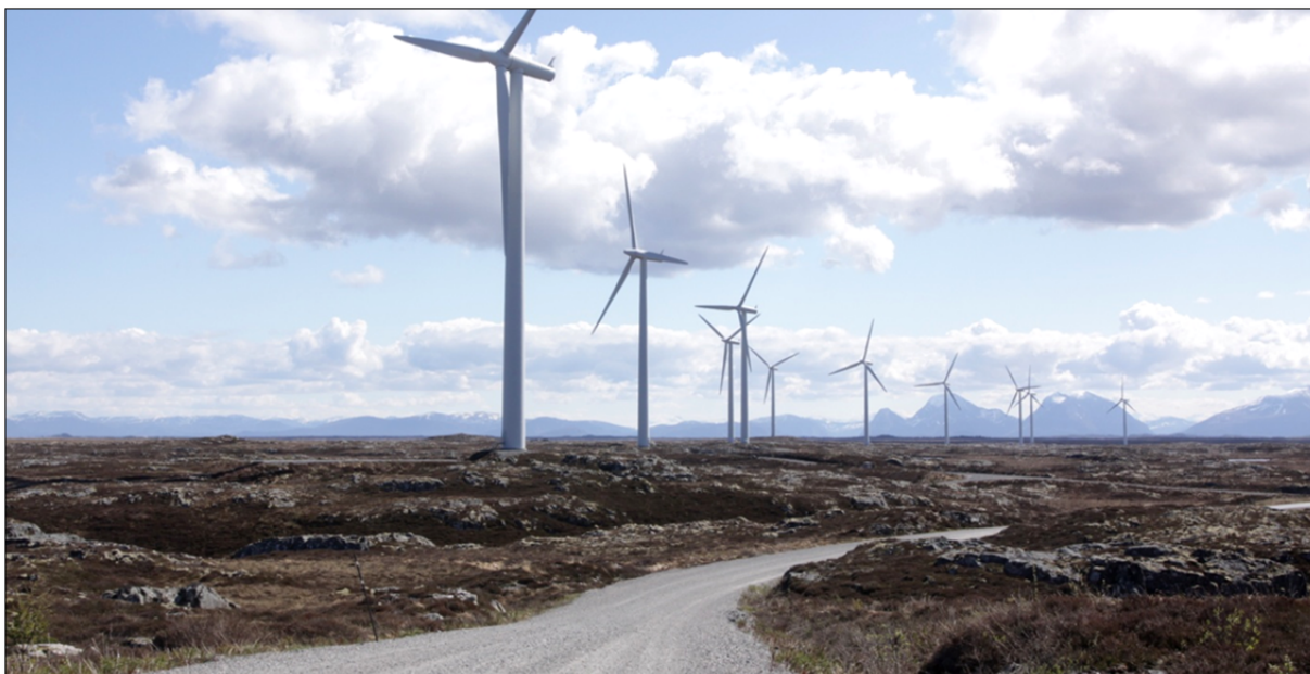
Figur 4. Smøla vindkraftverk med internveger og vindturbiner. Vegene som bygges i forbindelse med vindkraftverk har grusdekke og normalt en bredde på ca. 5 m pluss evt fyllinger/skjæringer. Adkomst- og internvegene på Hovatn Aust vindkraftverk vil også kunne brukes av grunneierne i forbindelse med tilsyn med beitedyr o.l.
