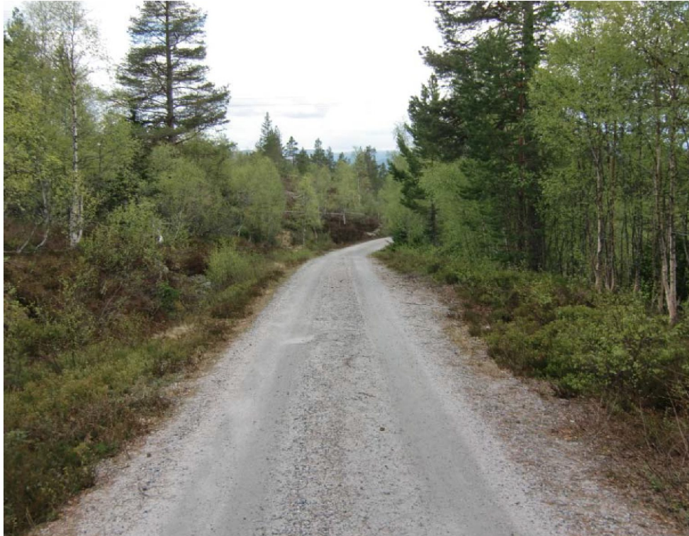
Figur 10: Anleggsveien mellom Haugetveit og Hovatn
