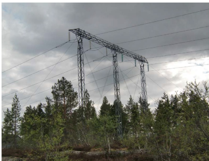
Figur 16: Otra Krafts 132 kV duplex linje ved Hovatn
