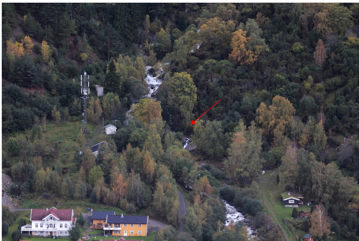
Kraftstasjonsområdet, ca. kote 70. Kraftstasjonens plassering er indikert med rød pil.
