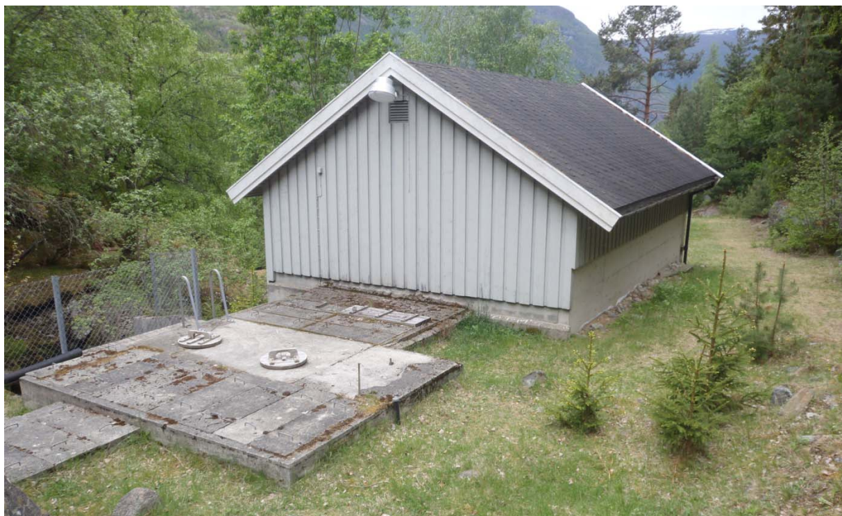
Inntak til Ofta vannverk
