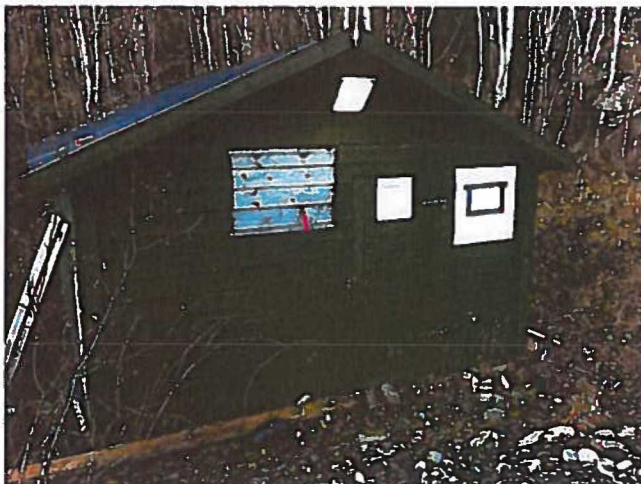
Bilde 1: Vannhus (overbygg)
