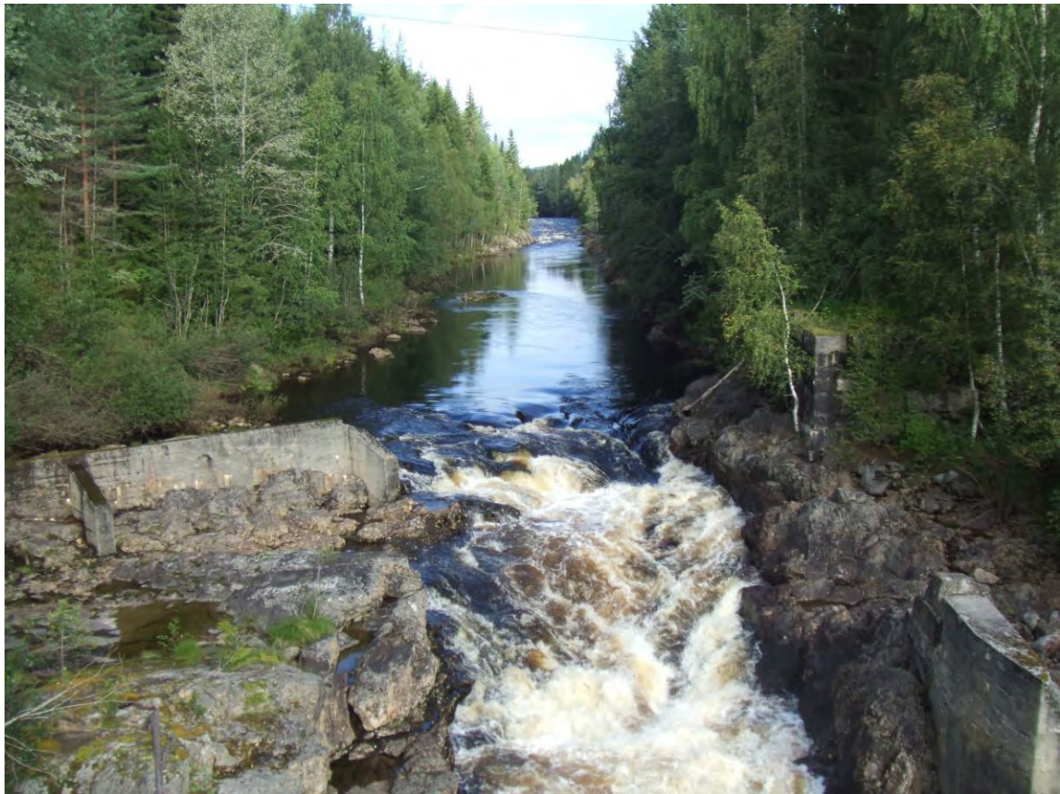
Bilde 4: Damrestene viser damplasseringen. Den første strekningen er smal og har fjell i elvesidene. Bakerst i bildet er det et kortere parti med noe fall. Bak/ovenfor dette fallet er vannspeilet på ca kote 97.
