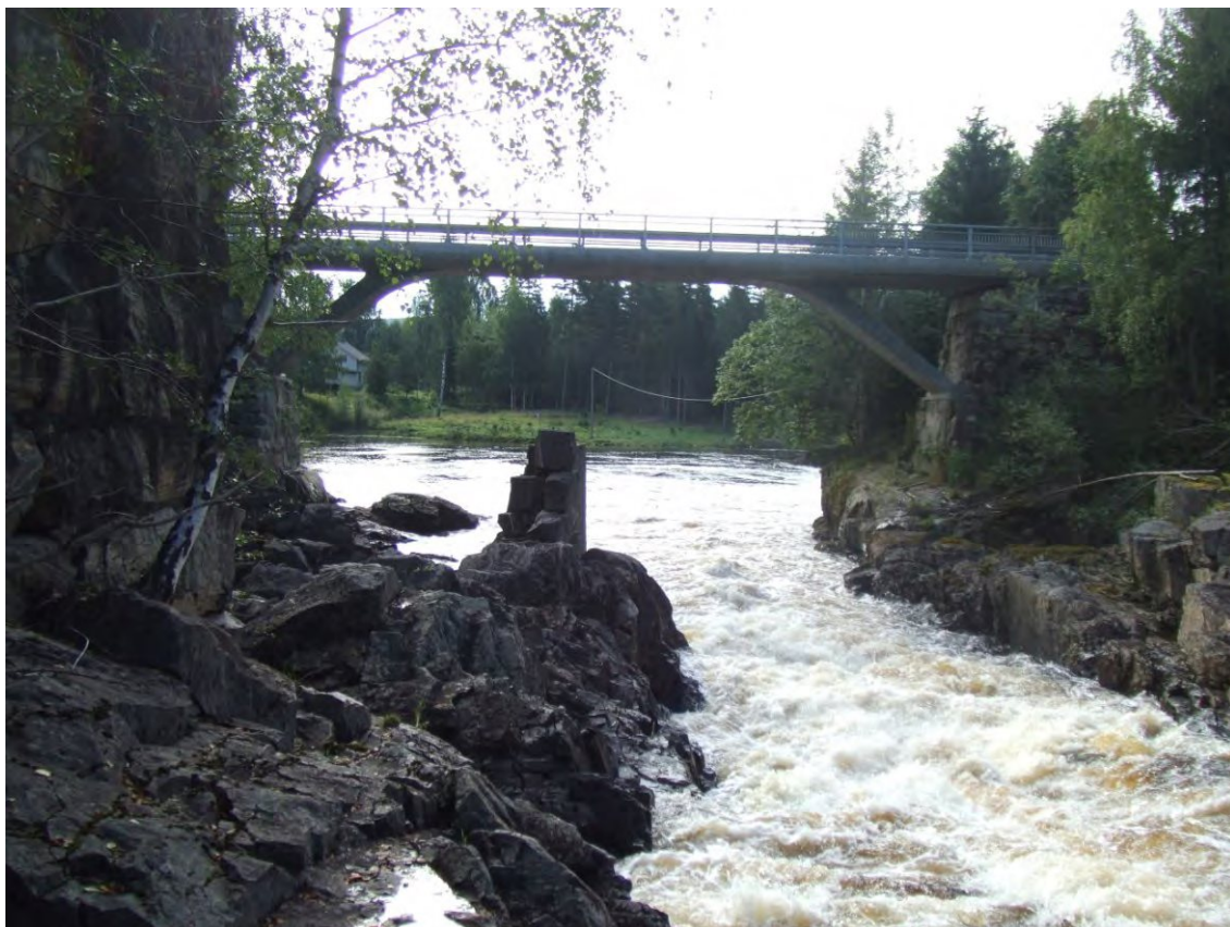
Bilde 2: I bakgrunnen samme hølen som på bilde 1. Fjellet i venstre bildekant vil sprenges bort for å gi plass for stasjon på venstre side av elvestrengen.
