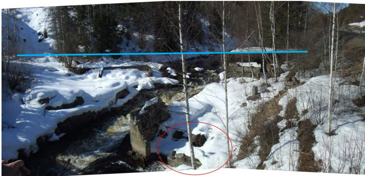
Bilde 3: Bilde tatt oppe fra brua. Stasjonstomt antydnet med rød sirkel. Dam vil bli der restene etter tidligere dammer står. Nivået på ny dam antydnet med blå strek.
