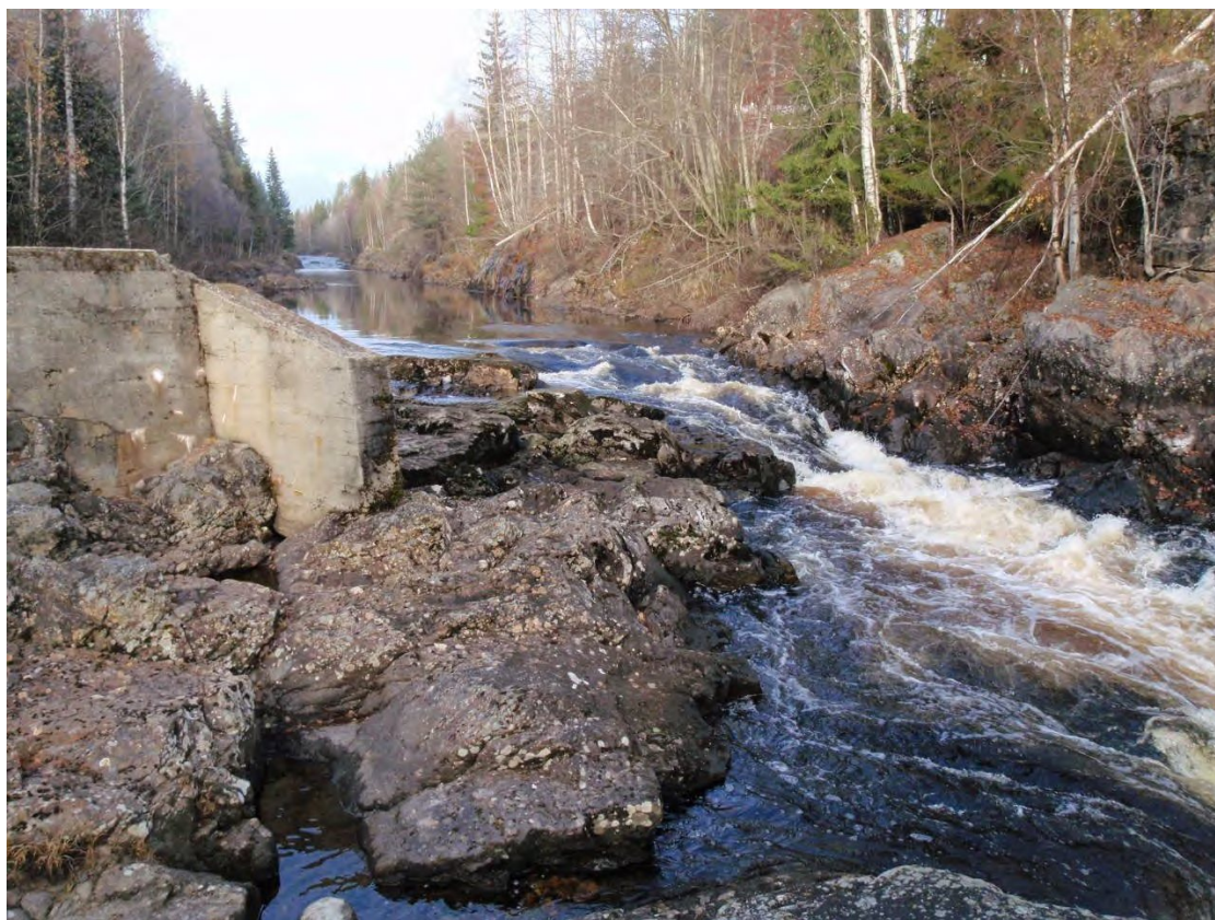
Figur 5. I området omlag midt på bildet må det bores, sprenges og graves for å få på plass fundament for demning til inntaket. Det vil medføre utslipp av slam og partikler til elva, som potensielt kan skade bestanden av elvemusling nedenfor fossen. (Foto; Bioreg AS ©).
