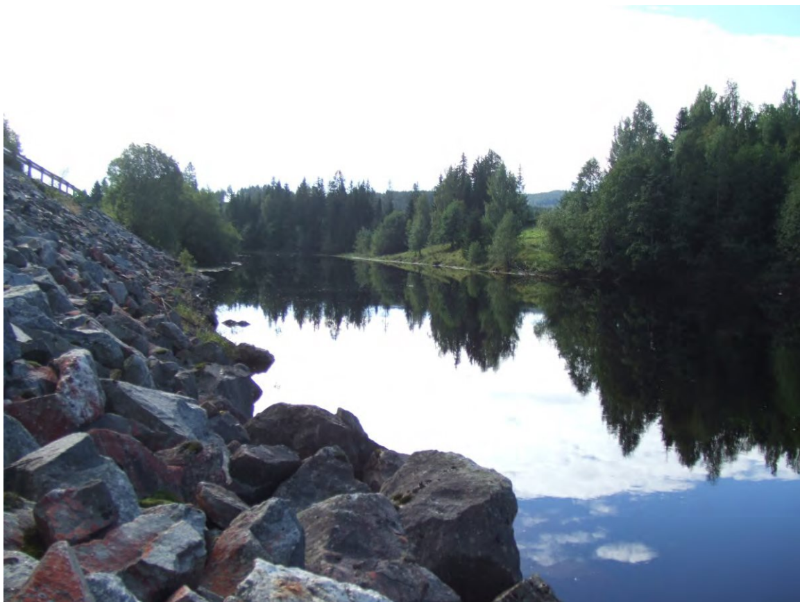
Bilde 6: Ca 1,7 km oppstrøms Stasjon. Steinfylling til venstre i bildet er vegfundament til riksveg 287.
