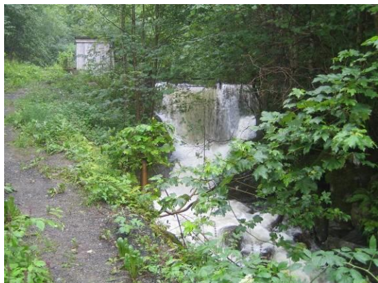
Overløp dam tidl. vassverk
