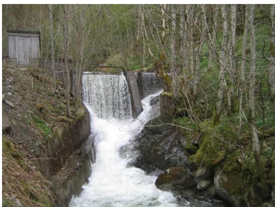
Overløp dam tidl. vassverk
