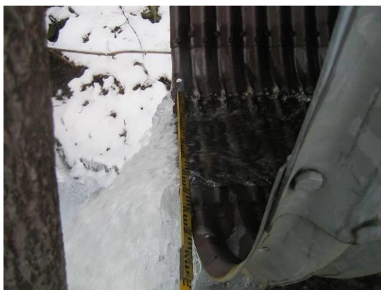
Risbruelva stikkrenne riksveg
