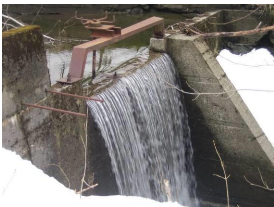
Overløp dam tidl. vassverk
