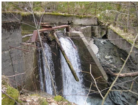
Overløp dam tidlegare vassverk
