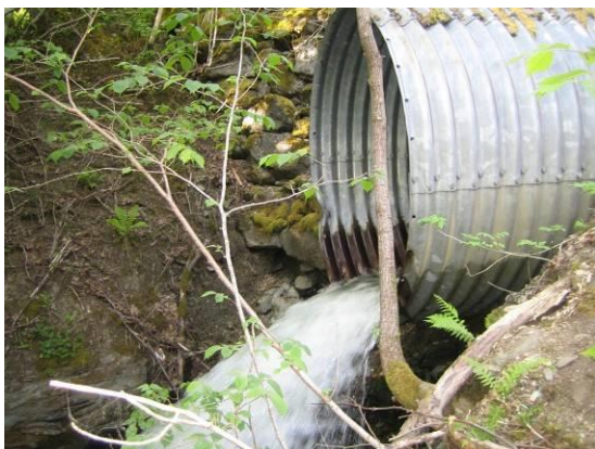
Risbruelva stikkrenne riksveg
