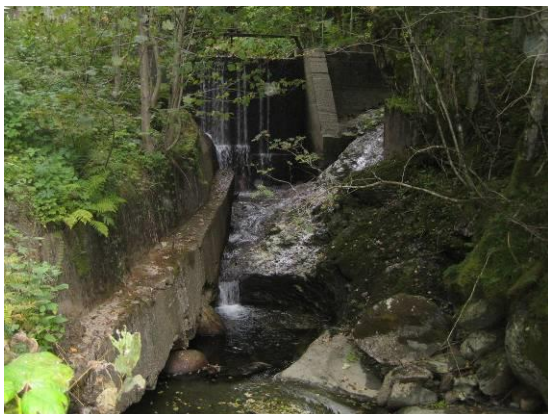
Overløp dam tidl. vassverk
