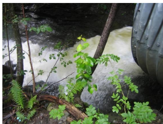
Risbruelva stikkrenne riksveg
