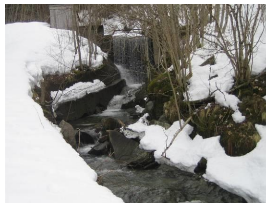
Overløp dam tidl. vassverk
