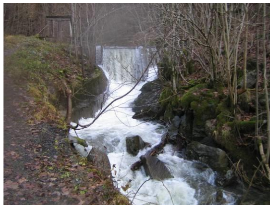
Overløp dam tidl. vassverk
