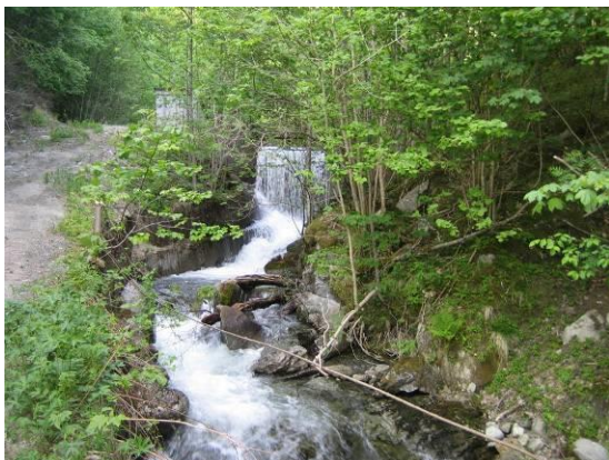
Overløp dam tidl. vassverk
