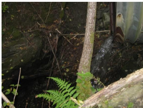
Risbruelva stikkrenne riksveg
