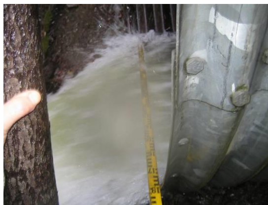
Risbruelva stikkrenne riksveg
