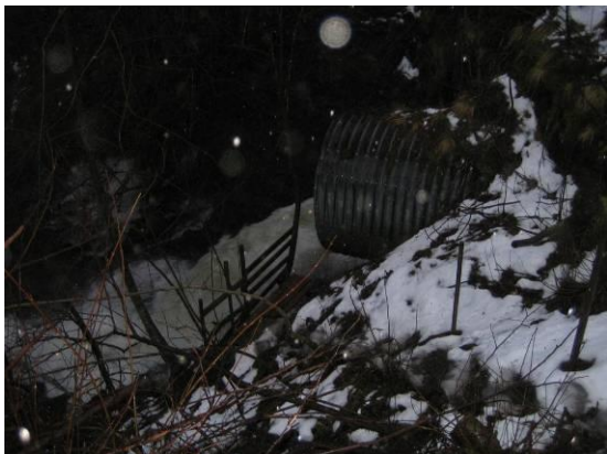
Risbruelva stikkrenne riksveg
