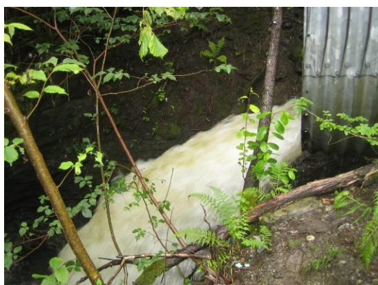
Risbruelva stikkrenne riksveg
