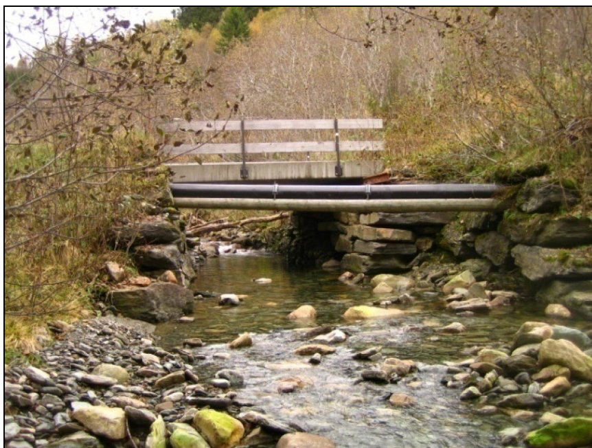
Figur 2 Traktorveg og avløpsleidning kryssar elva oppstrøms planlagt dam.
