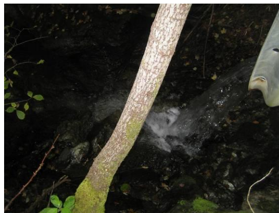
Risbruelva stikkrenne riksveg
