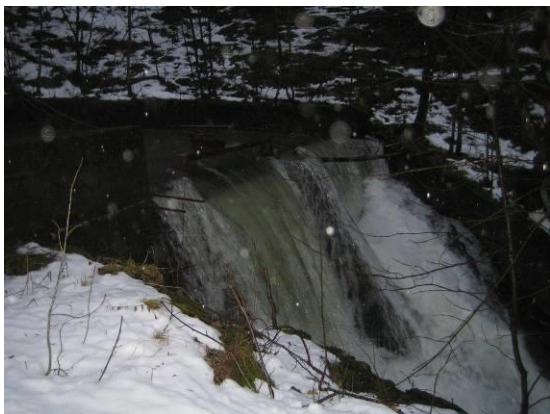
Overløp dam tidl. vassverk
