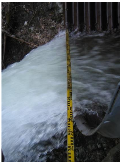
Risbruelva stikkrenne riksveg
