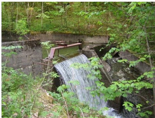
Overløp dam tidl. vassverk
