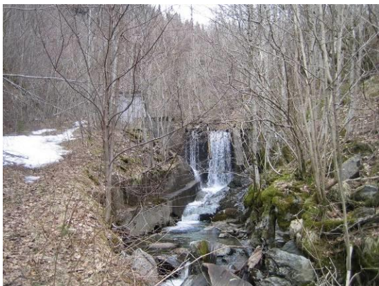
Overløp dam tidlegare vassverk
