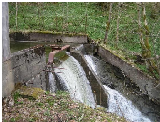
Overløp dam tidl. vassverk
