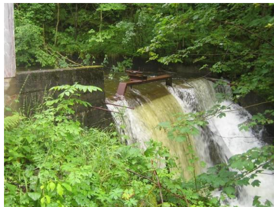
Overløp dam tidl. vassverk
