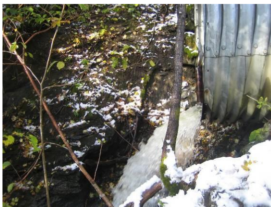
Risbruelva stikkrenne riksveg
