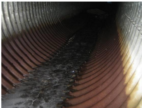
Risbruelva stikkrenne riksveg, is innover frå opning), renn litt vatn under isen, vanskeleg å observera mengd
