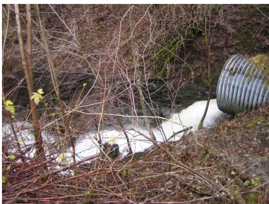
Risbruelva stikkrenne riksveg
