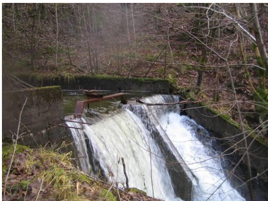
Overløp dam tidl. vassverk
