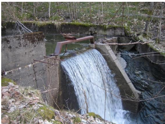
Overløp dam tidl. vassverk
