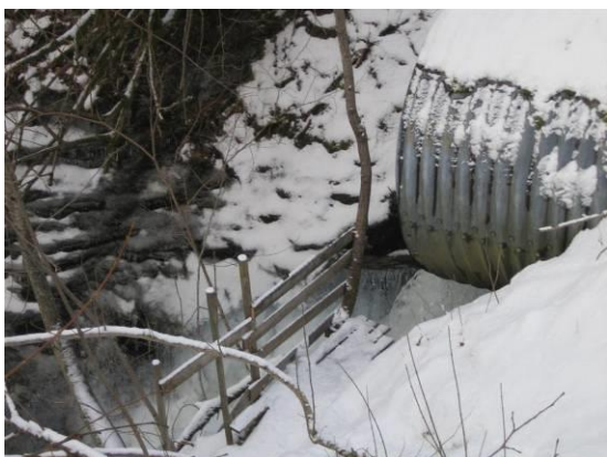
Risbruelva stikkrenne riksveg
