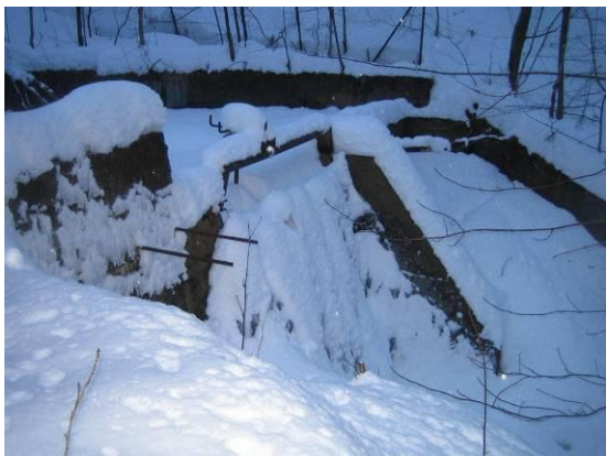
Risbruelva overløp dam tidl. vassverk
