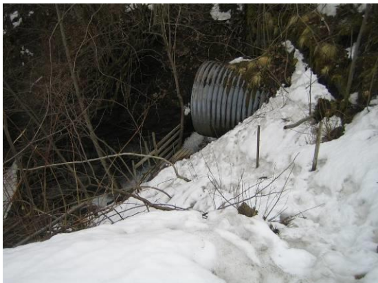
Risbruelva stikkrenne riksveg
