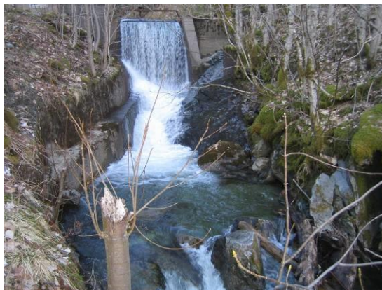
Overløp dam tidl. vassverk
