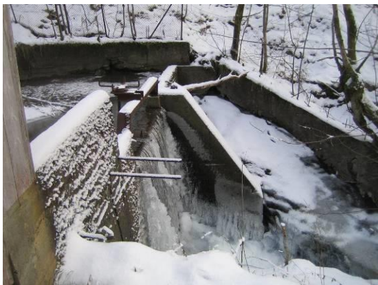
Overløp dam tidl. vassverk
