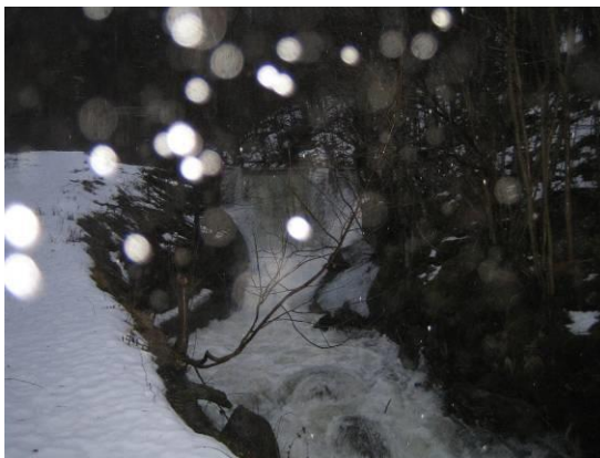
Overløp dam tidl. vassverk
