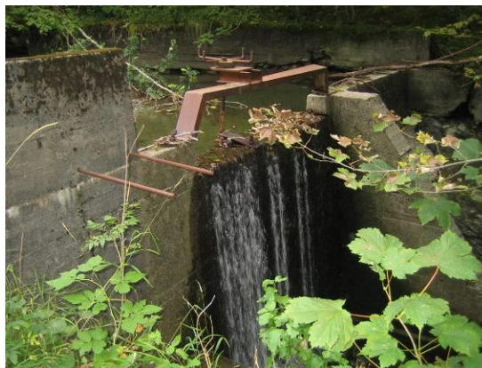
Overløp dam tidl. vassverk
