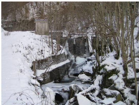
Overløp dam tidl. vassverk
