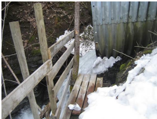
Risbruelva stikkrenne riksveg
