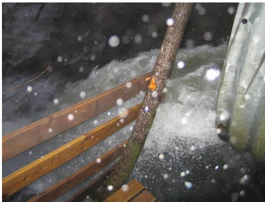
Risbruelva stikkrenne riksveg
