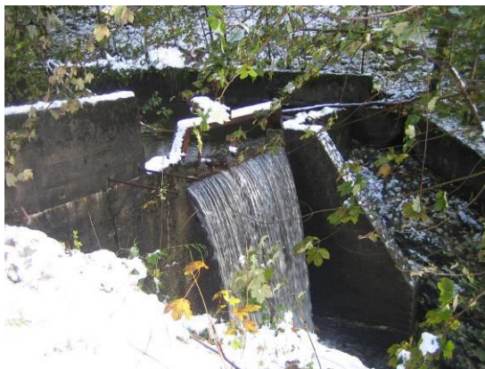
Overløp dam tidl. vassverk
