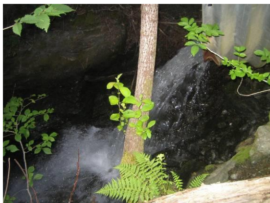
Risbruelva stikkrenne riksveg
