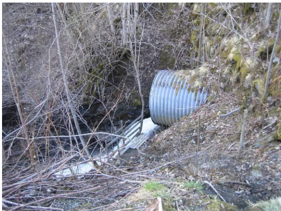
Risbruelva stikkrenne riksveg
