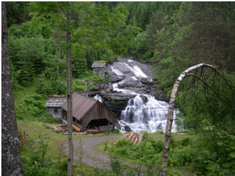
Fig. 19 Oppgangssaga nedstraums inntaket. Vassføringa er stipulert til å vera 200-200 l/s. Dato: 21.05.12.
