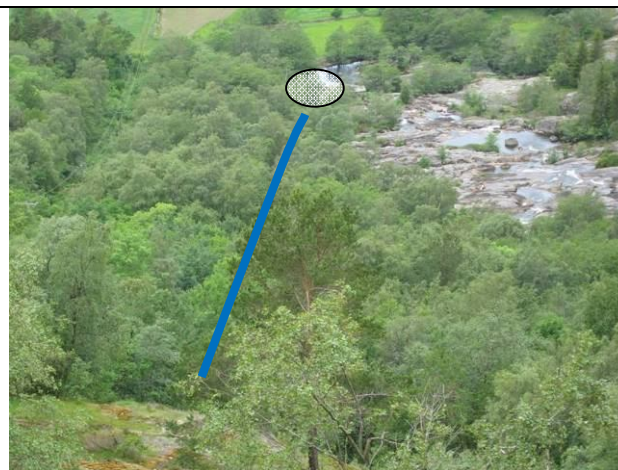
Bilde 5: Rørtrasé ovenfor stasjon. Foto: Elvekraft
