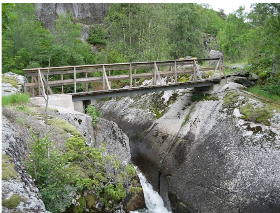
Bilde 14: Gangbru over til hytte på nordsiden av elva. Foto: Elvekraft.
