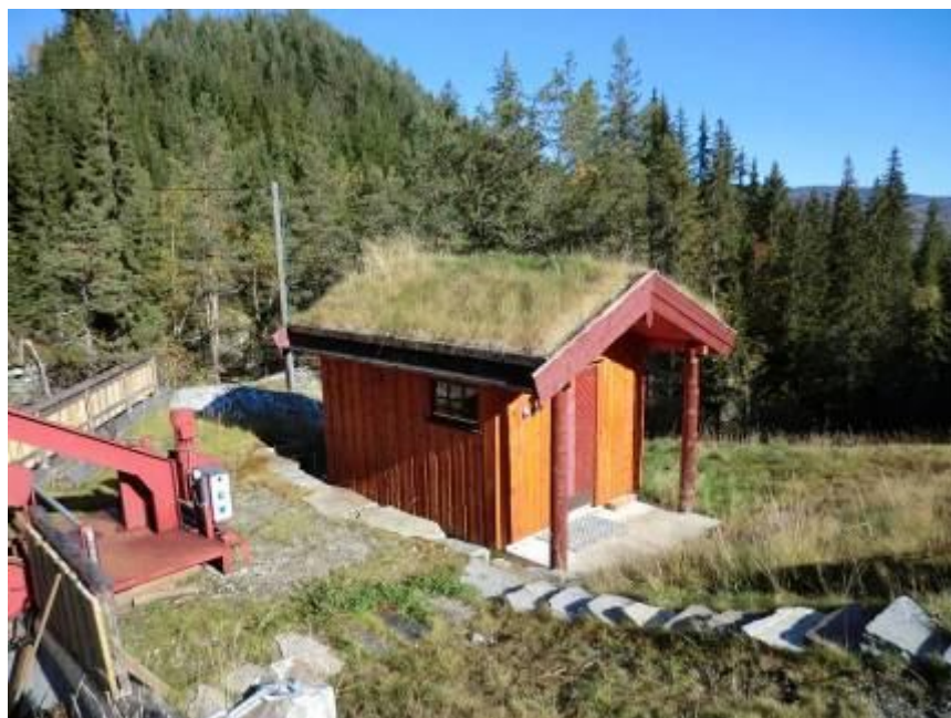
Bilde 3: Pumpehus, planlagt type. Foto: Elvekraft.
