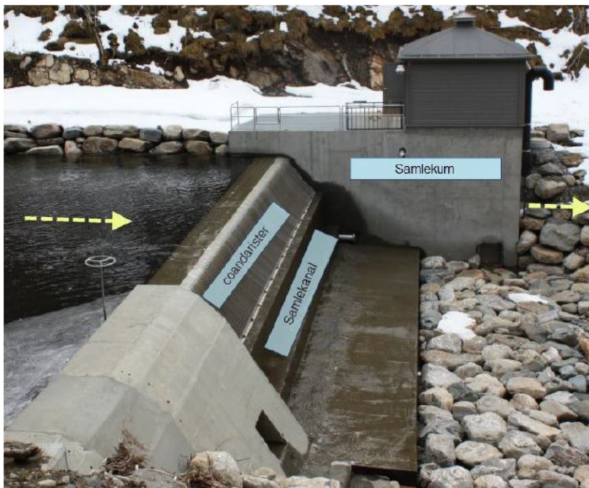
Figur 4. Coanda- inntak slik det er bygget i Dyrkorn kraftverk i Stordal kommune på Sunnmøre. Operatør for kraftverket er Tafjord Kraftproduksjon.
