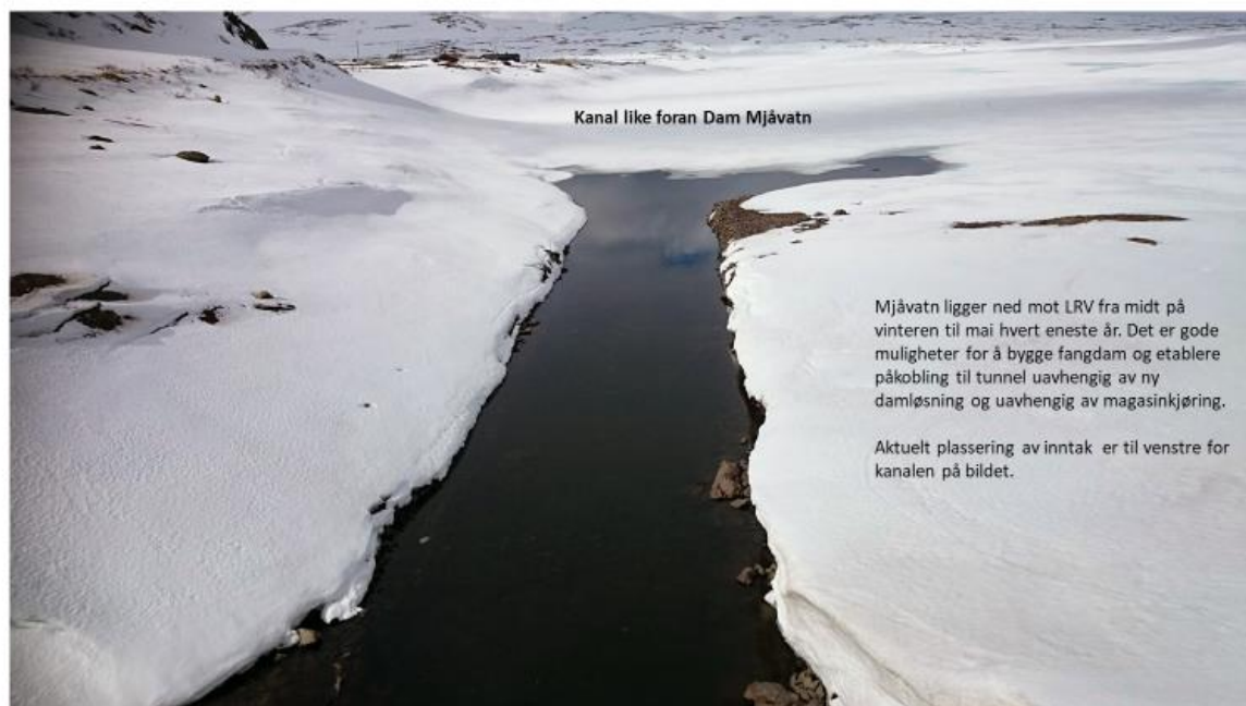
Kanal forran dam Mjåvatn
