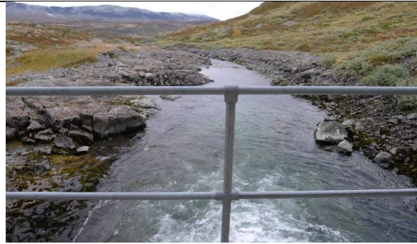
Fra dam Mjåvatn, estimert 1000 l/s
