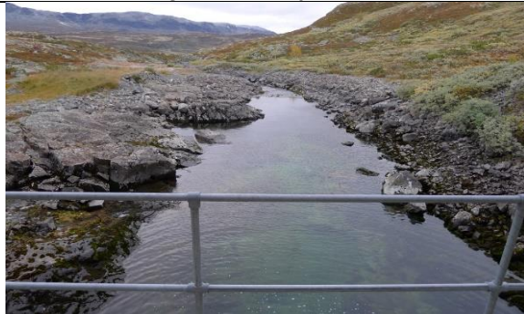
Fra dam Mjåvatn, estimert 250 l/s
