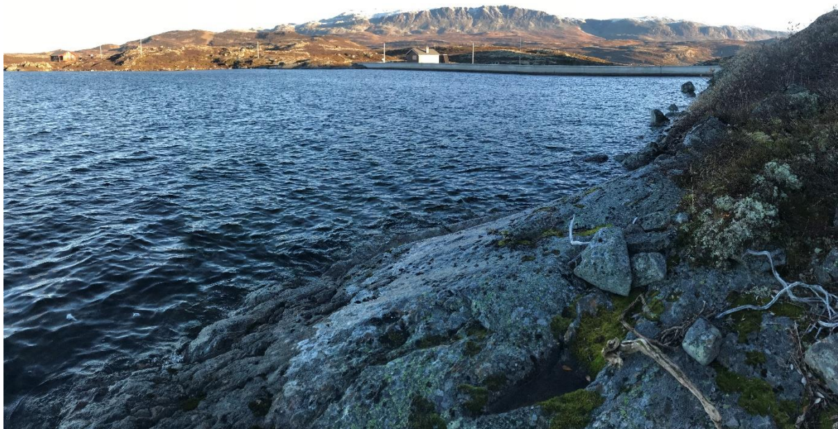
Dam Frosen i bakgrunnen. Inntakssted i forgunnen
