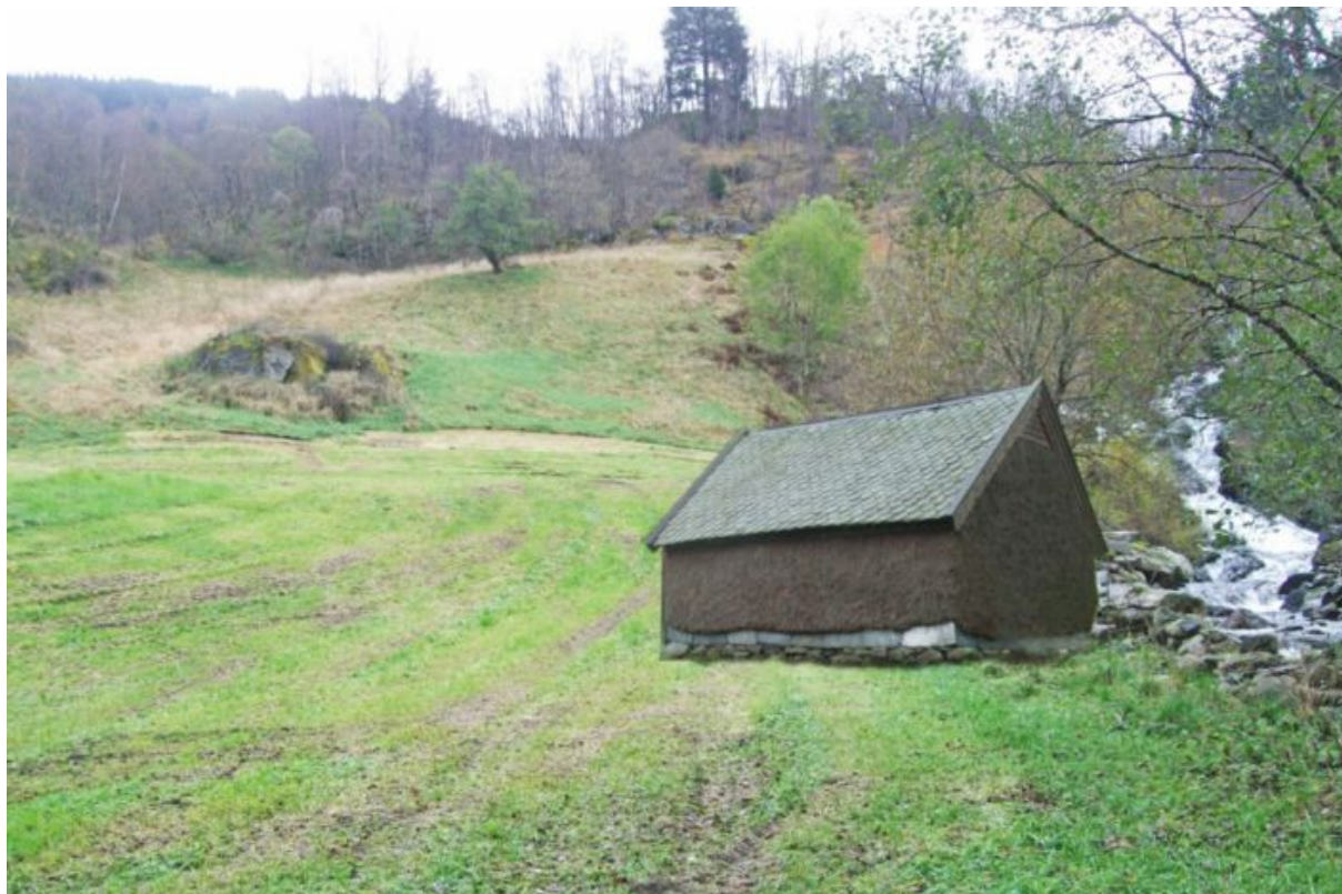
Figur 14: Kraftstasjonen plassert i terrenget
