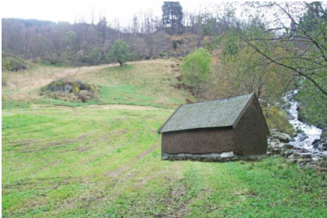
Fig. 6 Kraftstasjonen plassert i terrenget. Gjerstadfossen til høyre.
