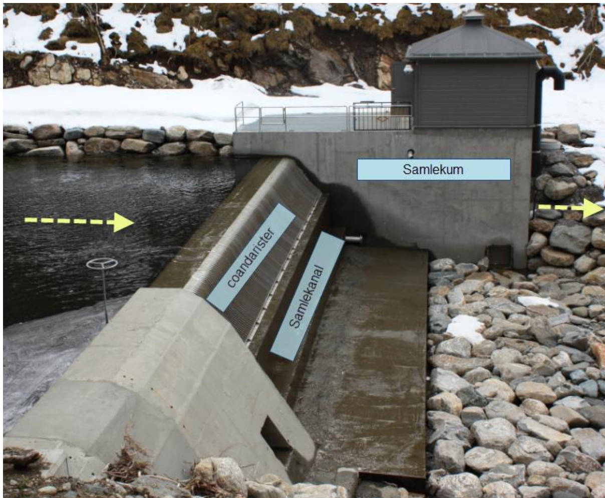
Figur 1: Eksempel på coandainntak.
