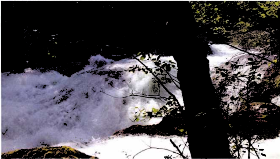
14 Kraftstasjonsområdet/utløpet, høg vassføring.
