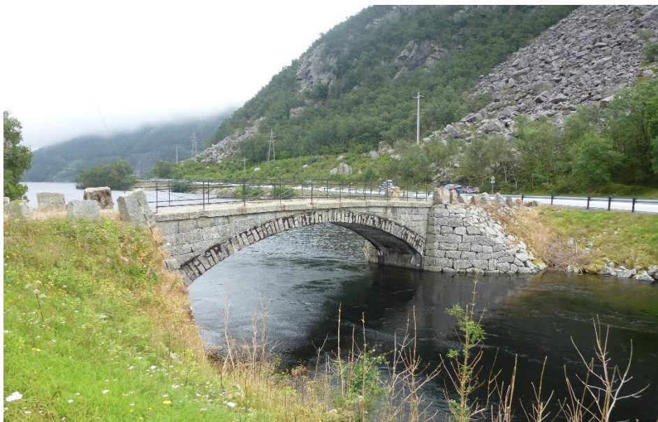
Figur 3.8. Rage bru mot vest. Eksisterende ledningsnett i bakgrunnen.
