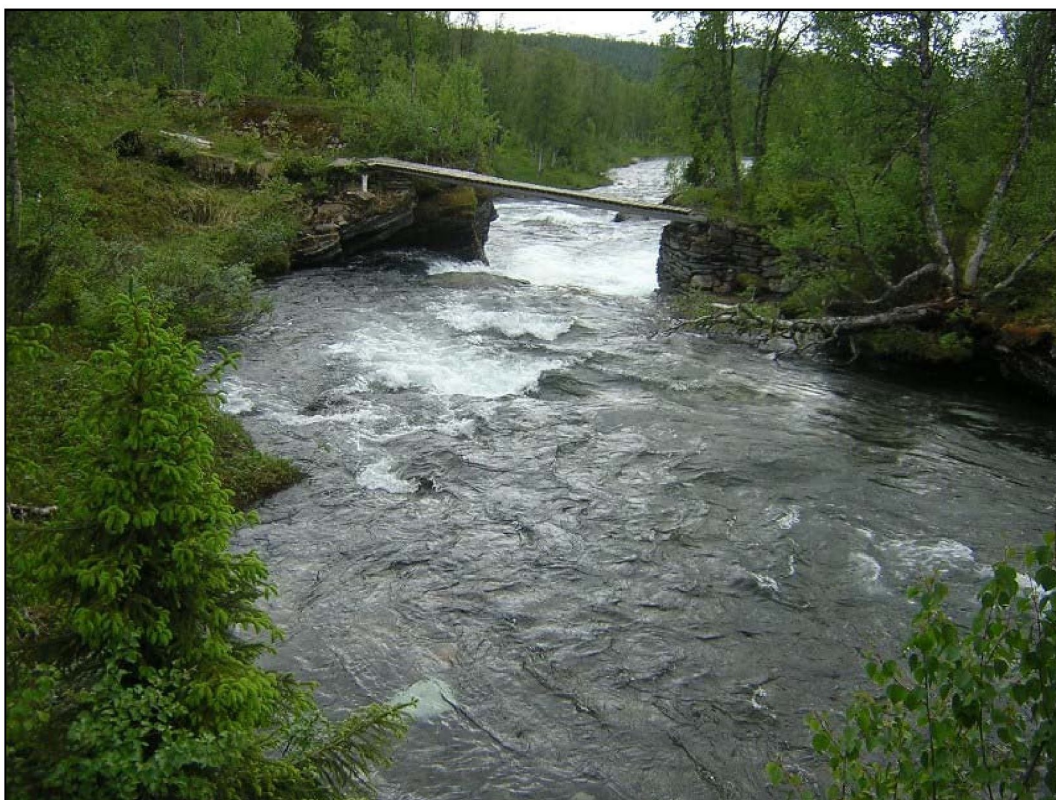
Kraftstasjonsområdet. Kraftstasjonen er plassert nedenfor brua på østlig bredd.
