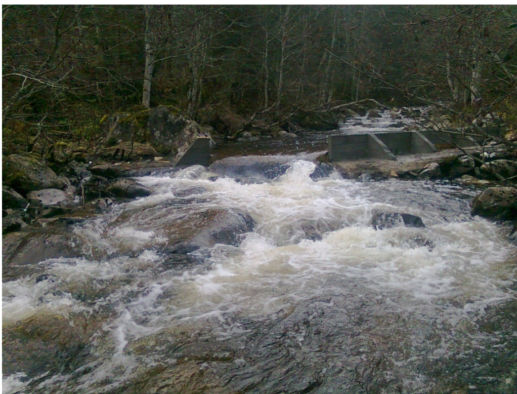
Bildet viser måledam støpt etter at den første forsvant i stor vannføring. Vannføring på bildet viser 1050 l/sek
