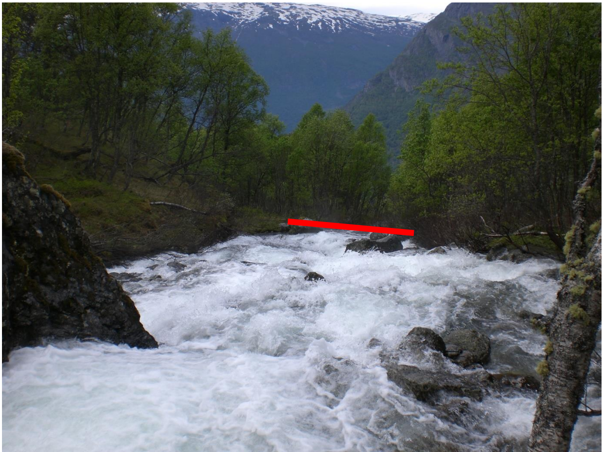
Bilde 14: Bildet viser hvor inntak og dammen blir sett ovenfra. Vannføring ca. 750 l/s.
