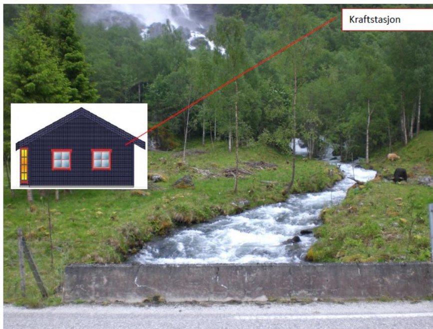
Bilde 4: Bildet viser nederste del av Åselvi sett fra Rv. 55. Man ser også nederste del av fossen. Kraftstasjonen skal bygges ca. ved treklyngen som ligger helt i venstre bildekant. Vannføring ca. 750 l/s.
