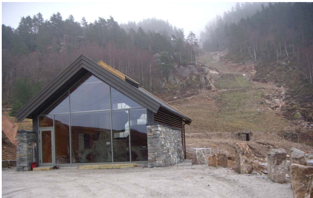
Bilde: Småkrafts standard for kraftstasjonsbygg.
