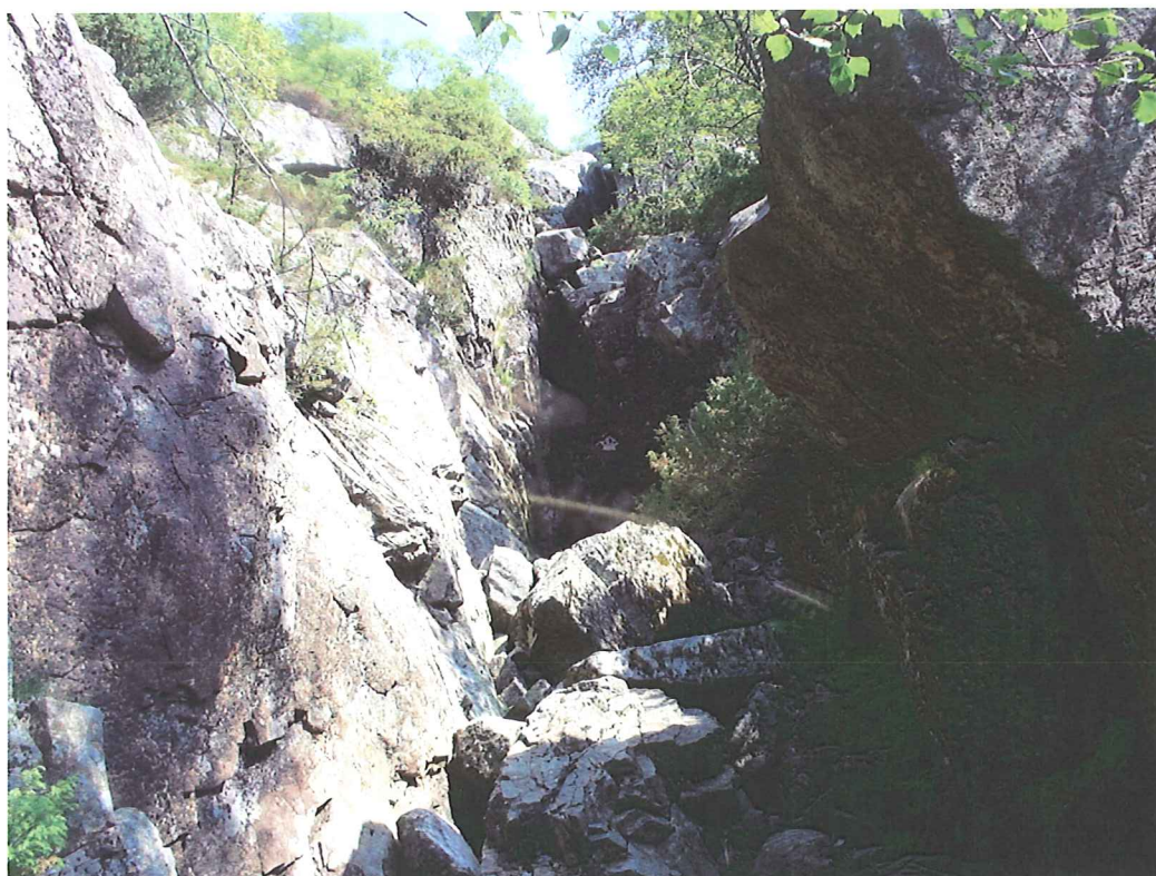
Bilde 8: Tverrbekk (markert svakhetssone i fjell) som krysser rørtraceen.
