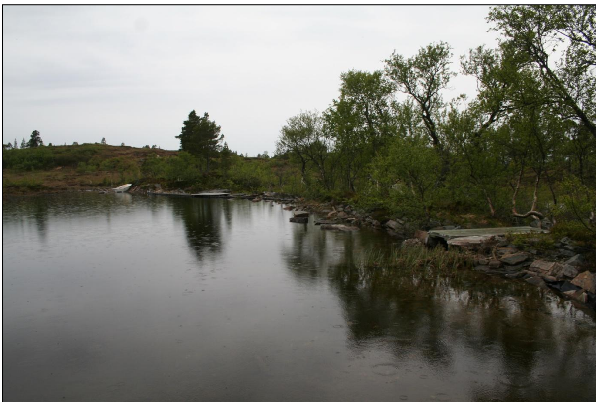
FIGUR 13: DAM I UTLØPET AV SJØASÆTERVATNET, SETT FRA OPPSTRØMS SIDE.
