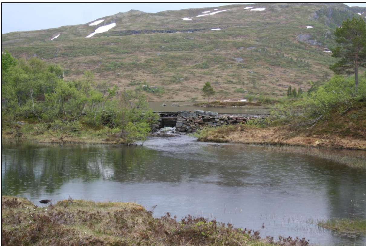
FIGUR 12: BILDE AV DAM I UTLØPET AV SJØASÆTERVATNET, SETT FRA NEDSTRØMS SIDE.
