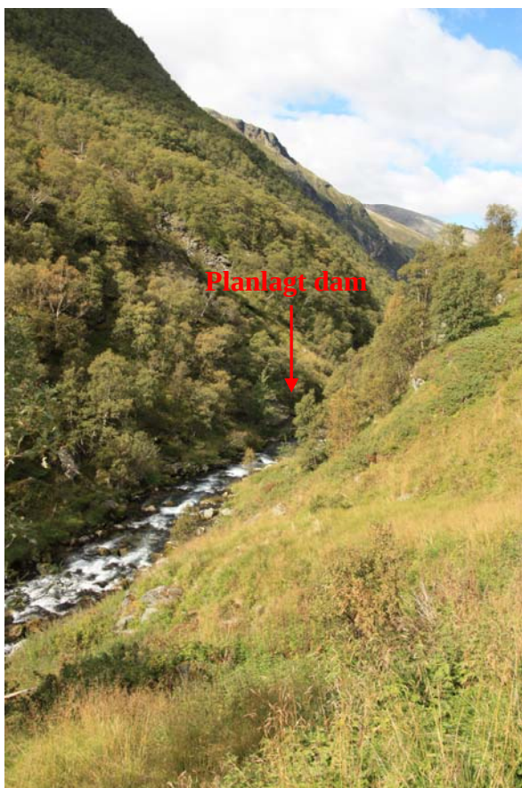
Dam- og inntakssted Tynjadalen kraftverk
