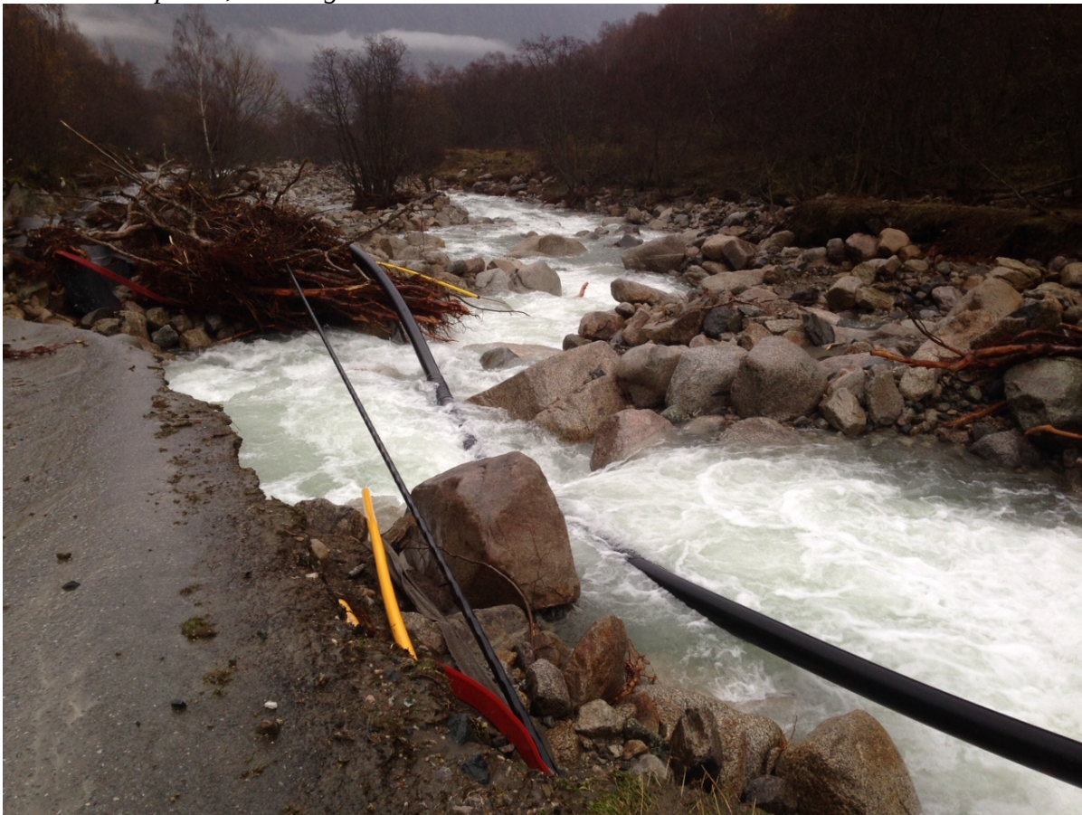
Store skader på vei, kabel og elveleie.
