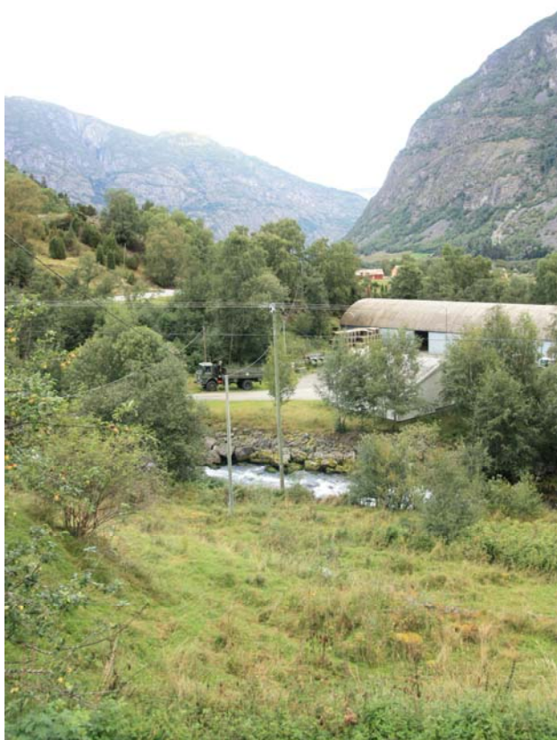
Forsvaret sitt lager ved kraftstasjonsområdet til Fosseteigen.
