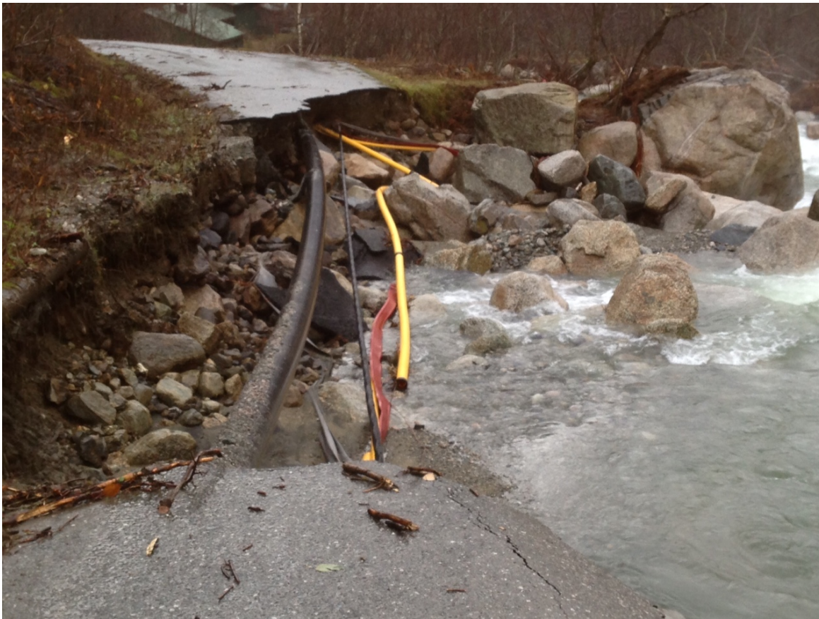
Bilde fra området ved planlagt kraftstasjon
