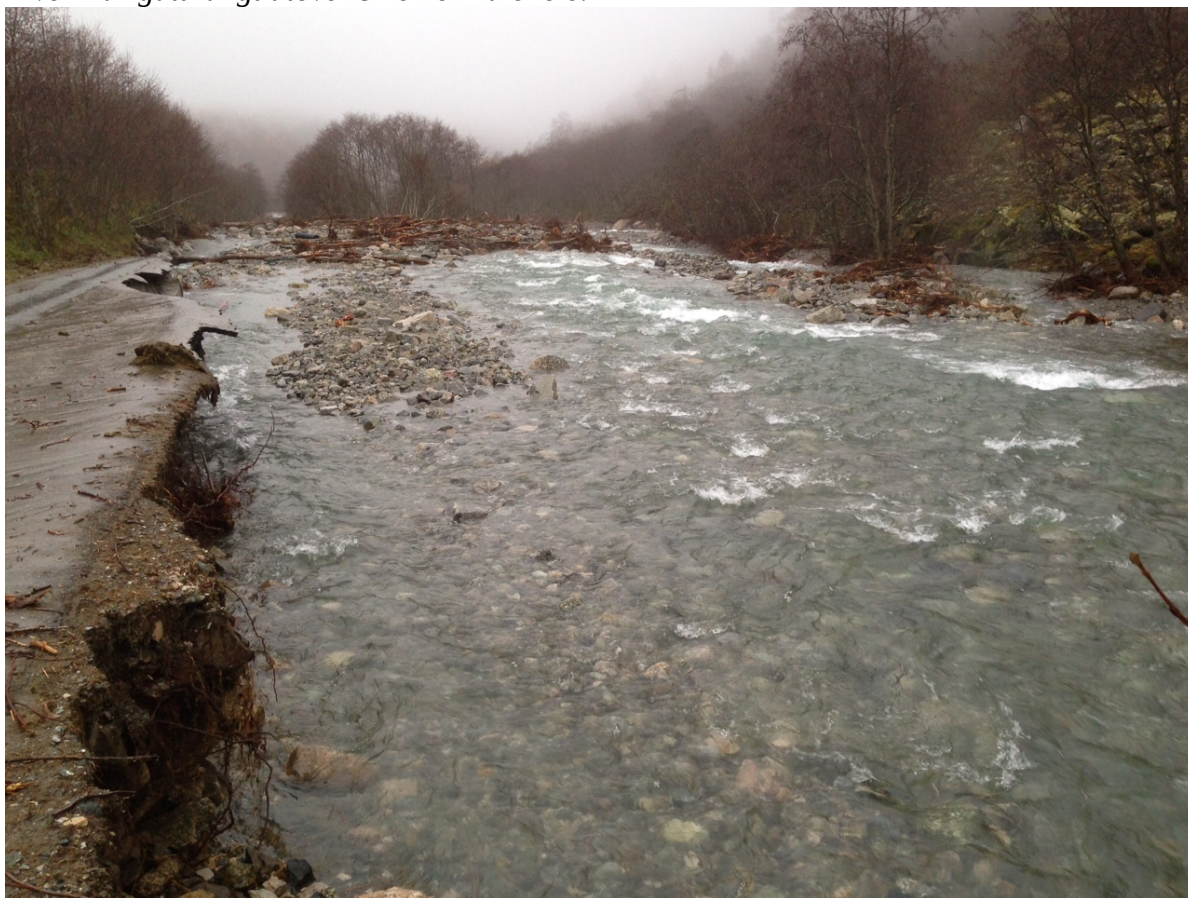
Skade på veien opp Tynjadalen.
