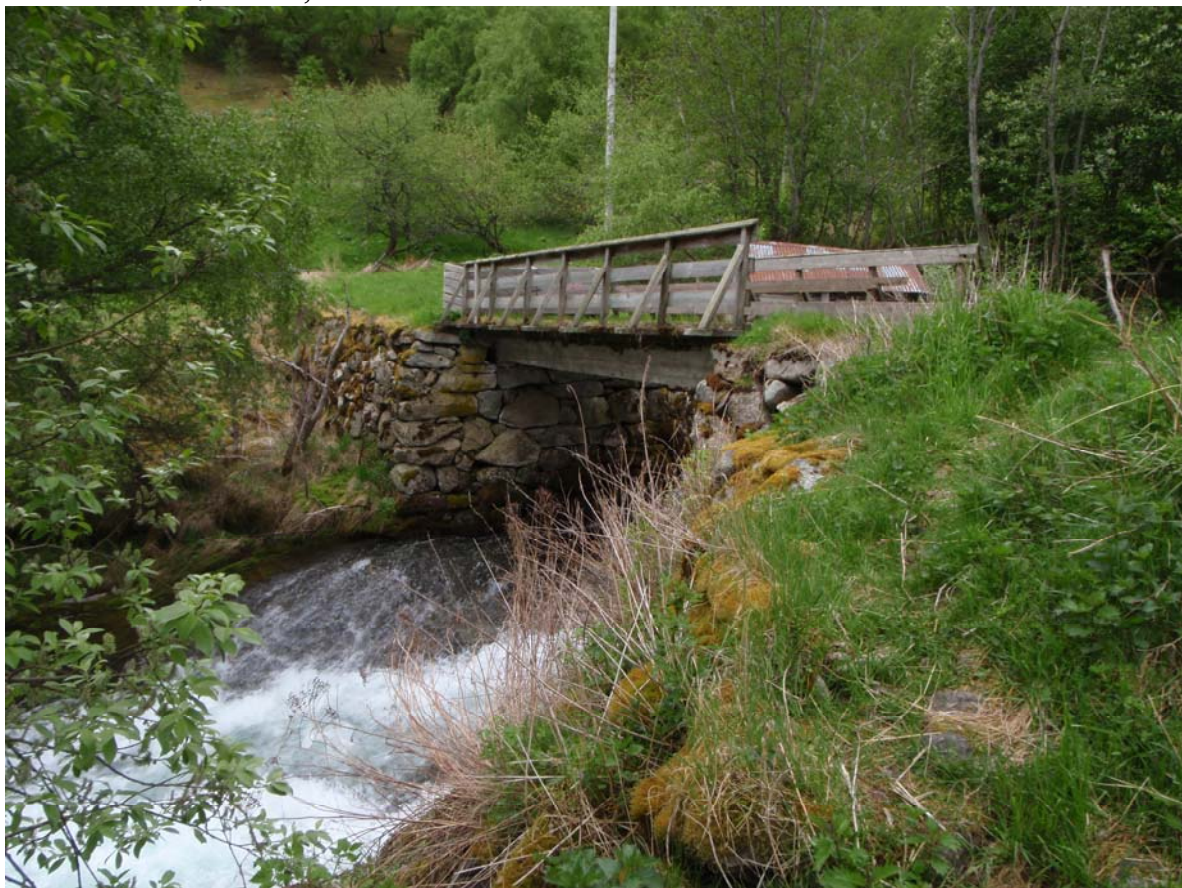
Eksisterende bru over Kuvelda, kote 65.
