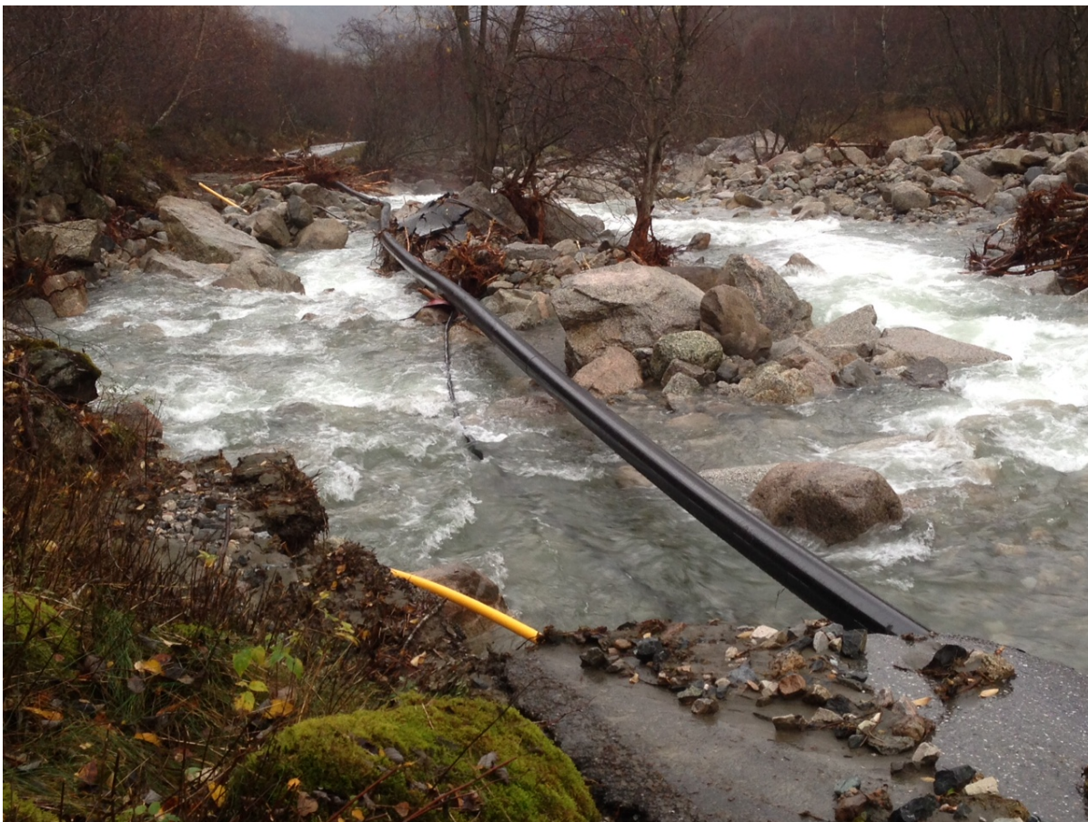
Store skader på vei, kabel og elveleie.
