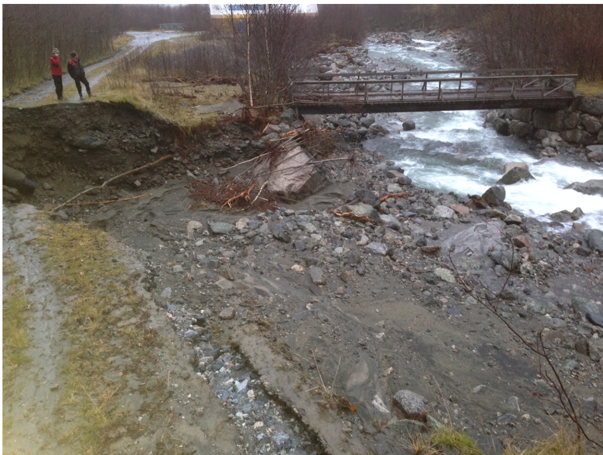
Elveleie, vei og lagerbygning 430 m nedstrøms planlagt kraftstasjonsplassering. Bildet viser også en bru over Kuvelda.
