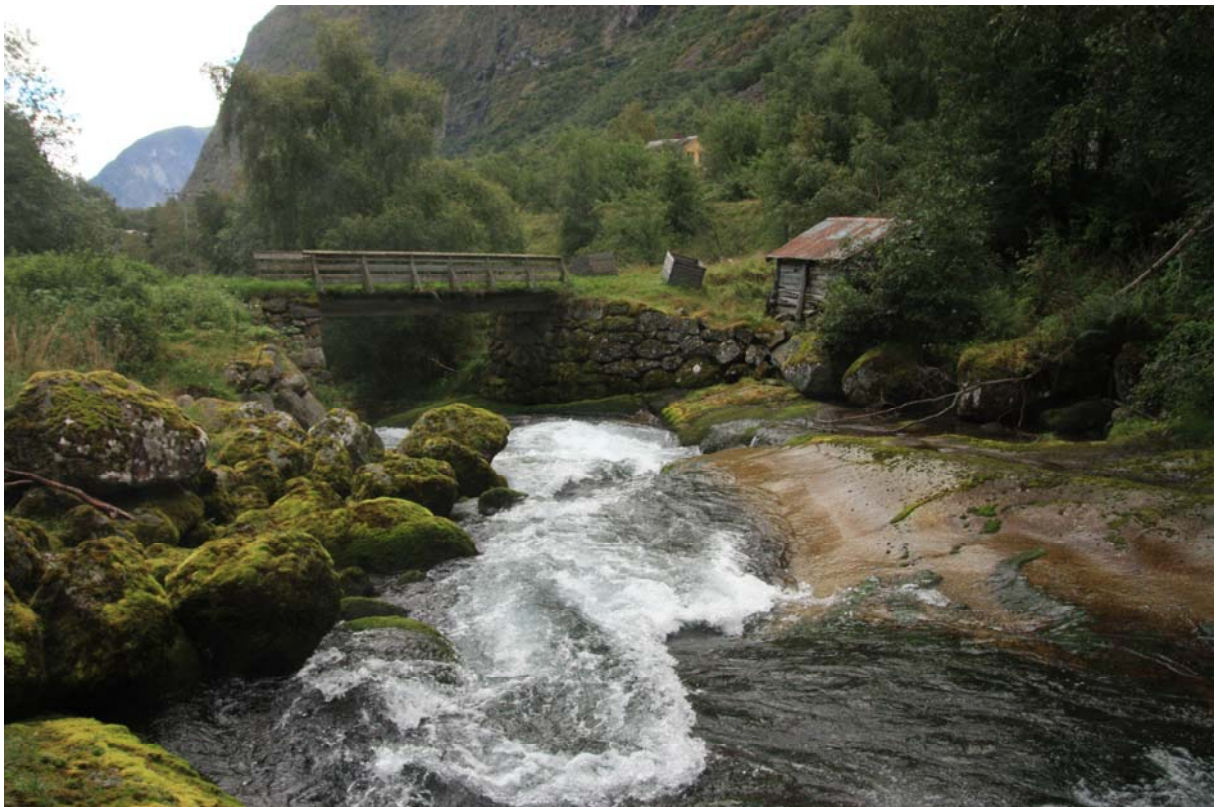
Kuvelda. Bildet tatt like oppstrøms bru kote 63. Dato: 03.sep.2010. Estimert vannføring er 0,55 m 3 /s.
