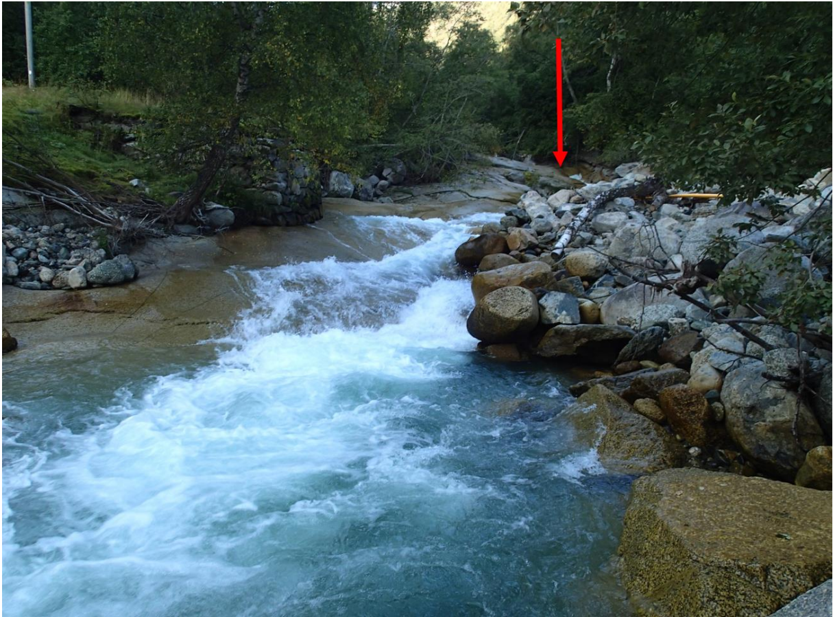
Figur 7 Kuvelda like nedstrøms vandringshinderet, som er merket med pil på bildet.
