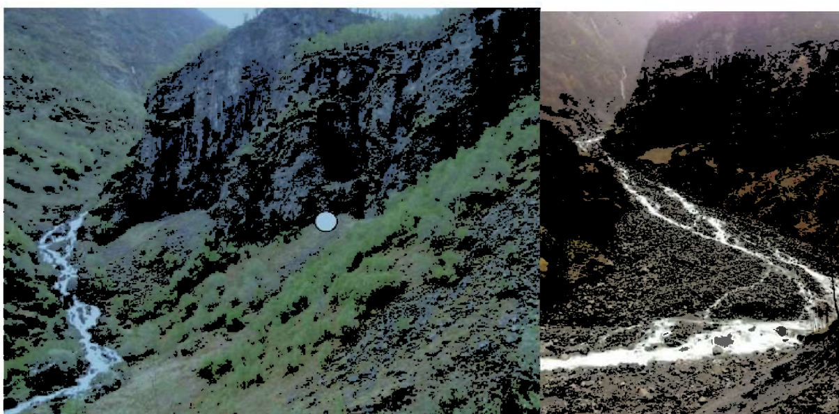
Venstre: Tynjadalsbotnen. Viser påhogg for tunnel.
