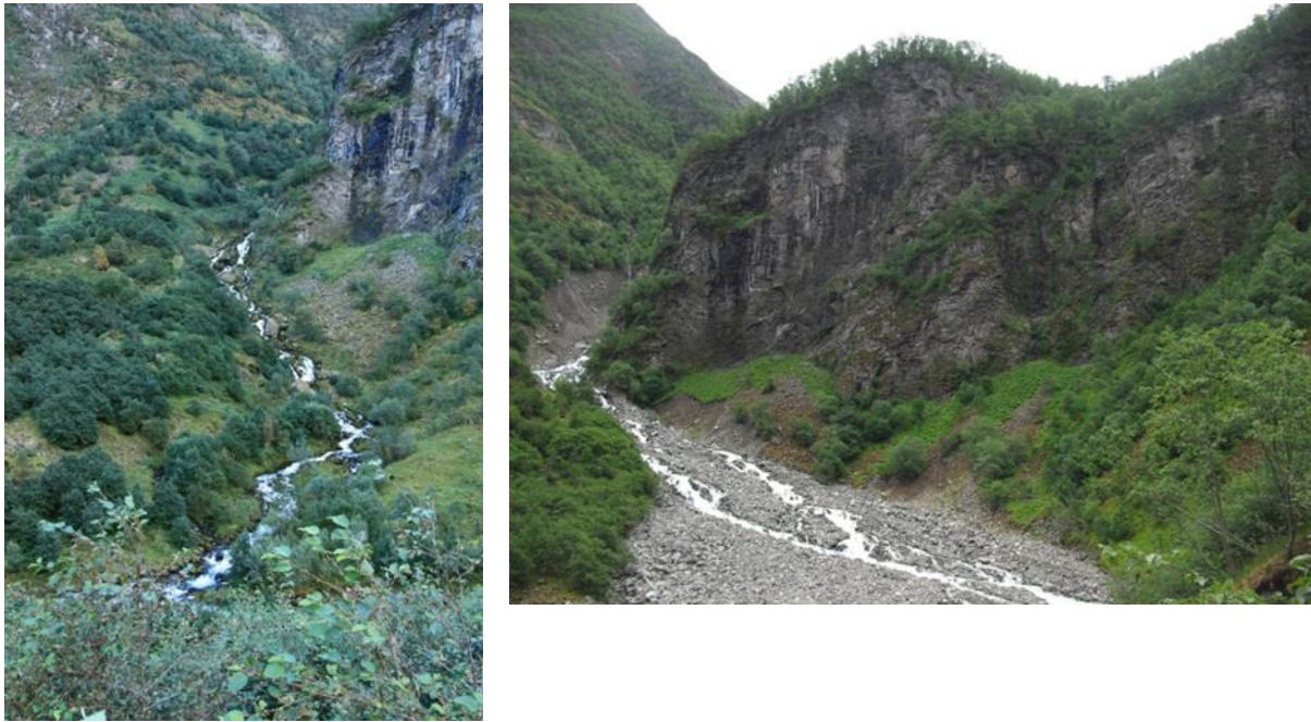
Figur 2: Til venstre: Nedre del av bekkekløfta Trollelii-Tynjadalsbotn i 2010, før flommen. Foto: Hentet fra konsesjonssøknaden Til høyre: Nedre del av bekkekløfta Trollelii-Tynjadalsbotn i 2016, etter flommen. Foto: NVE
