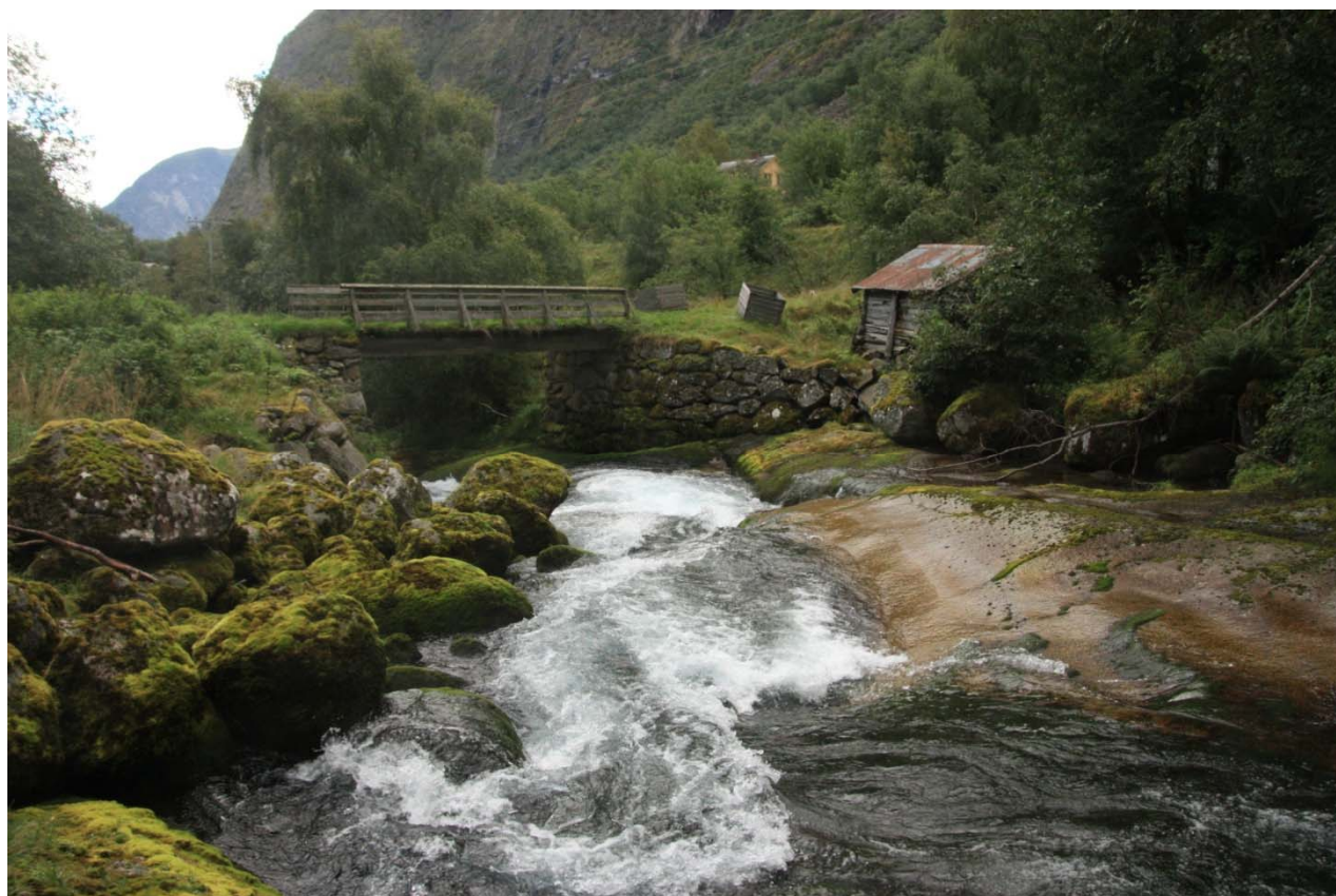
Figur 3-14 Bro og kvernhus ved Kuvelda. Broen ble ødelagt under flommen i 2014
