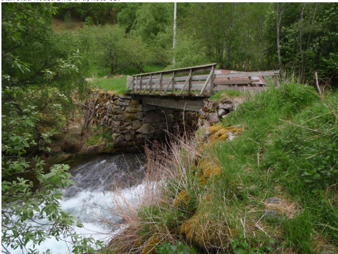
Eksisterende bru over Kuvelda, kote 65.
