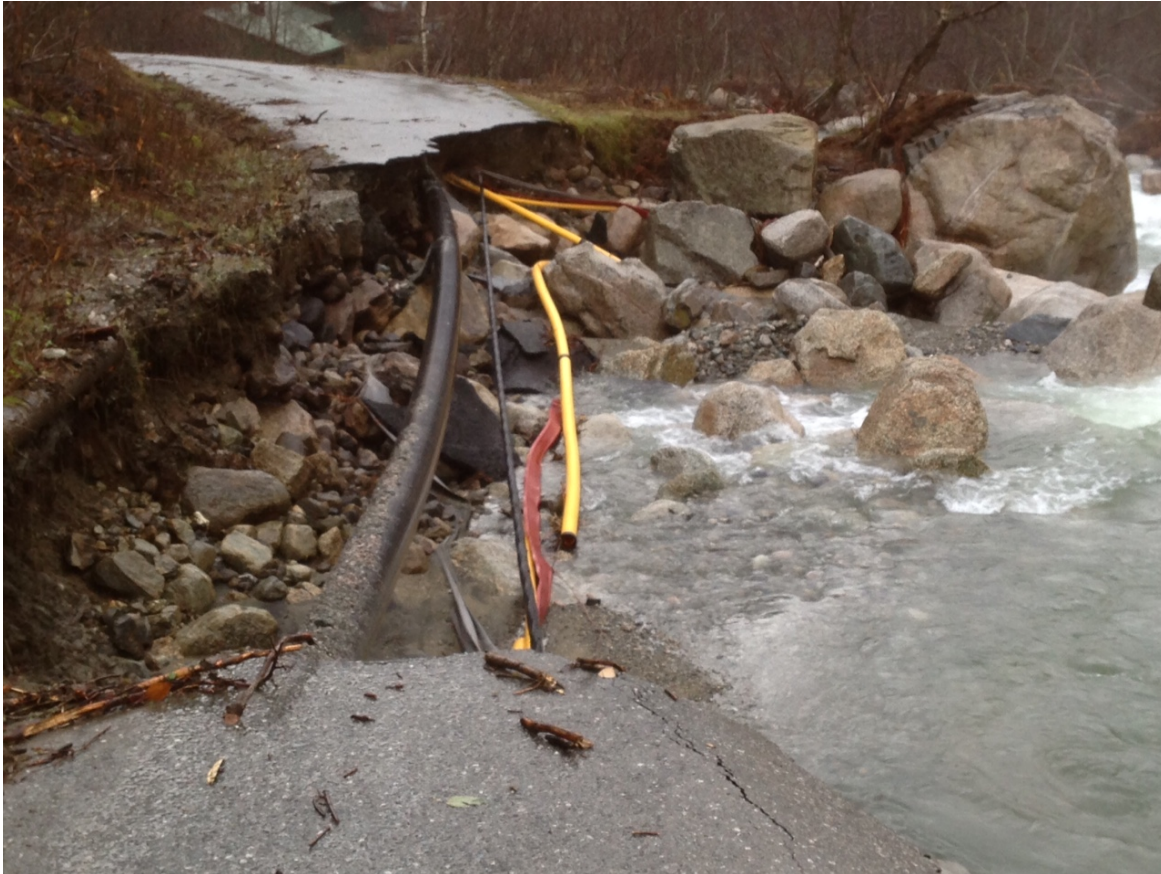
Bilde fra området ved planlagt kraftstasjon
