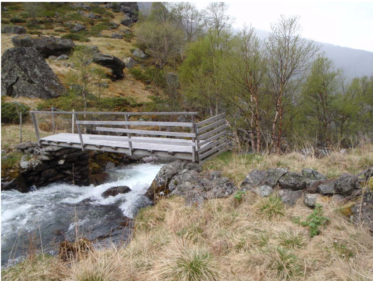
Eksisterende gangbrua over Kuvelda, kote 600.
