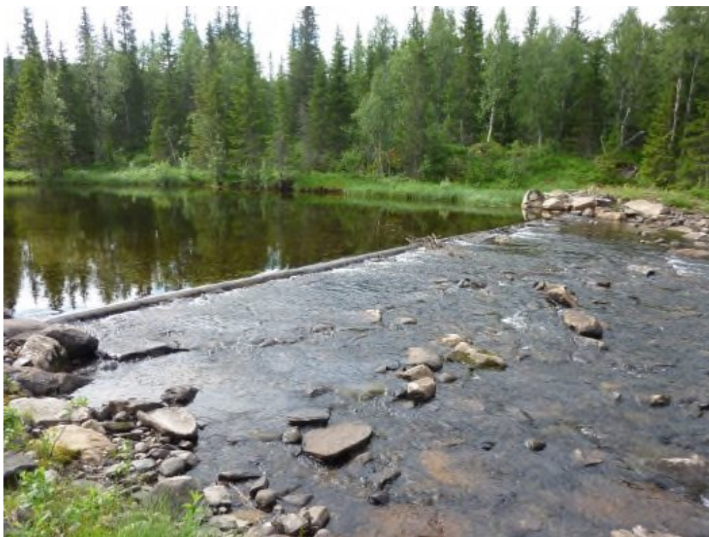
Figur 1. Treterskel 300 meter oppstrøms samløpet mellom Sandåa og Kjæråa, utgjør et fall på maks noen titalls cm. Dette er trolig ubetydlig for ørret og småblank.
