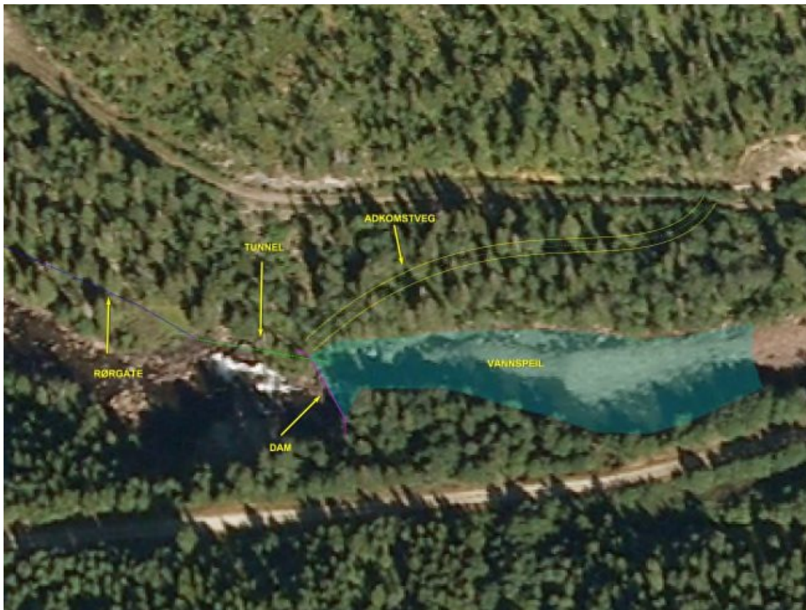
Figur 2 Detaljert oversikt over inntaksområde med dam, vannspeil etter oppdemming, tunnel, rørgate og vei. Figur fra NTE.
