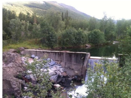
Figur 10 Eksisterende dam sett i retning sør
