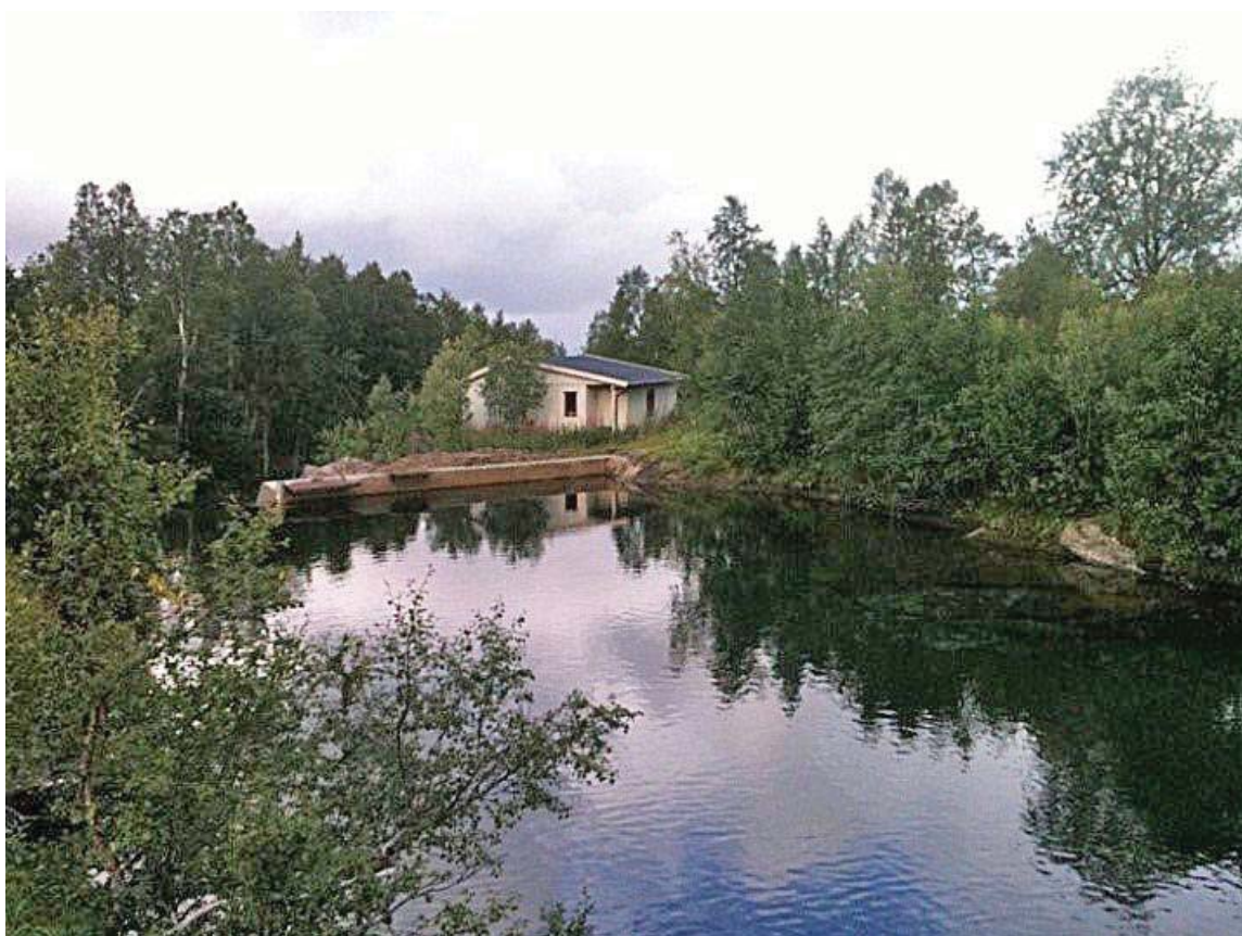
Inntaksbasseng og eksisterende dam på ca kote 200 moh sett i retning nord.
