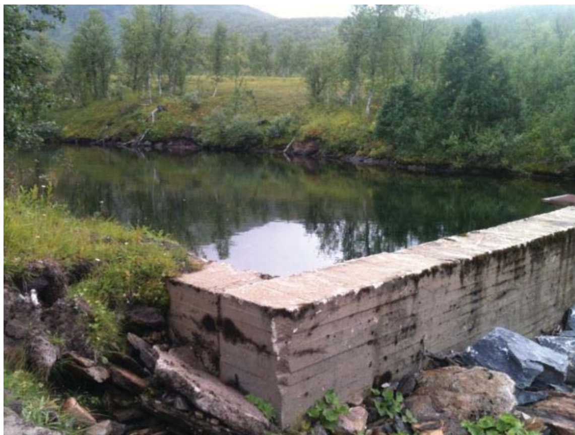
Inntaksbasseng og østre del av eksisterende dam sett i retning sørvest.
