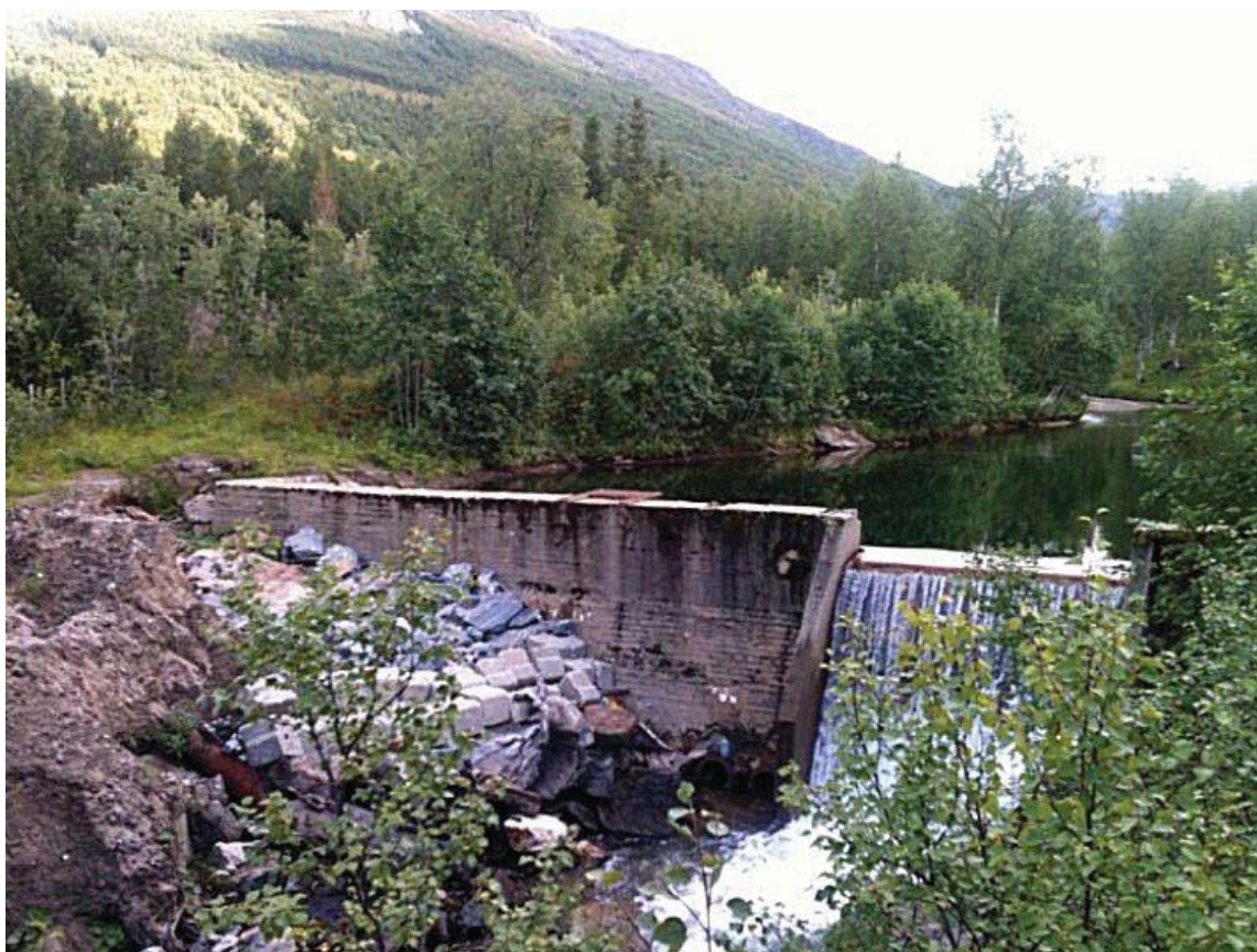
Eksisterende dam sett i retning sør.
