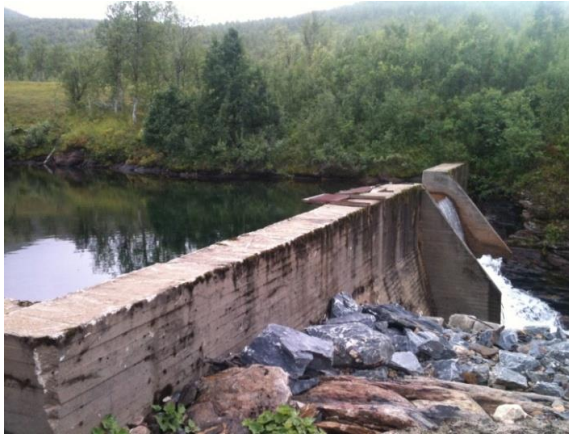
Figur 3 Eksisterende dam ved tenkt inntaksplassering
