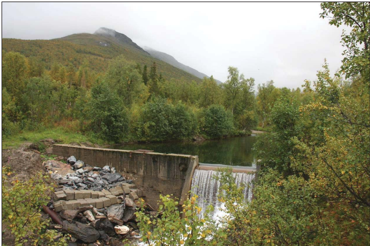
Figur 3. Inntaket til Middagselva kraftverk ligger i inntaksdam for eksisterende drikkevannsforsyning. Rørgata vil gå ut i høyre billedkant. I bakgrunnen sees Middagsfjellet Foto: Ole Kristian Spikkeland.
