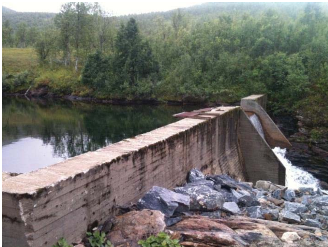
Eksisterende dam sett i retning sørvest.
