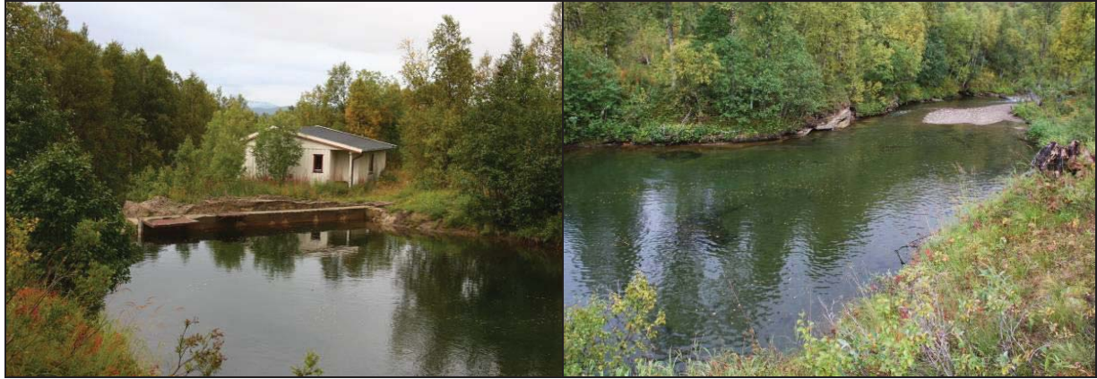
Figur 23. Middagselva ved inntaket til eksisterende drikkevannskilde på kote 200, som også skal bli kraftverksinntak. Det kan bli aktuelt å heve vannstanden 1,5-2 meter. Foto: Ole Kristian Spikkeland.
