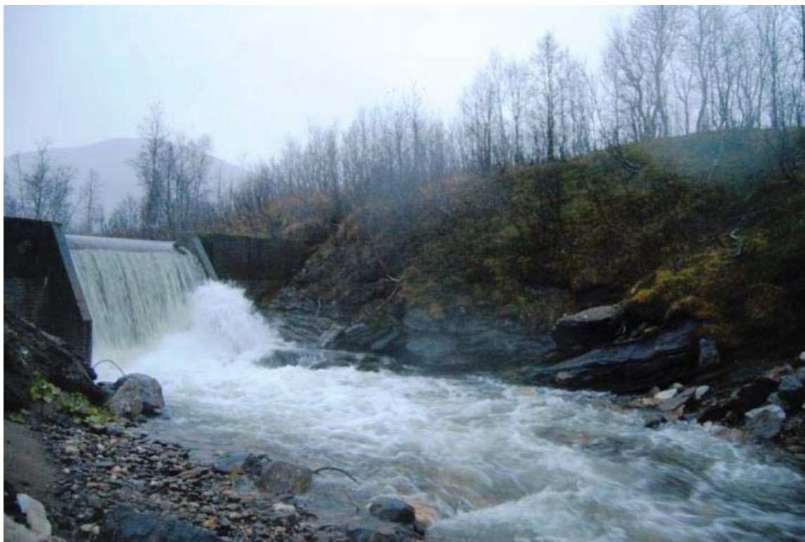
Eksisterende dam sett i retning sørvest. Lukehus etableres på vestsiden av elva i forbindelse med dammen. Rørgaten føres ut på vestsiden av elva i det område som vises i midten og til høyre i bilde.
