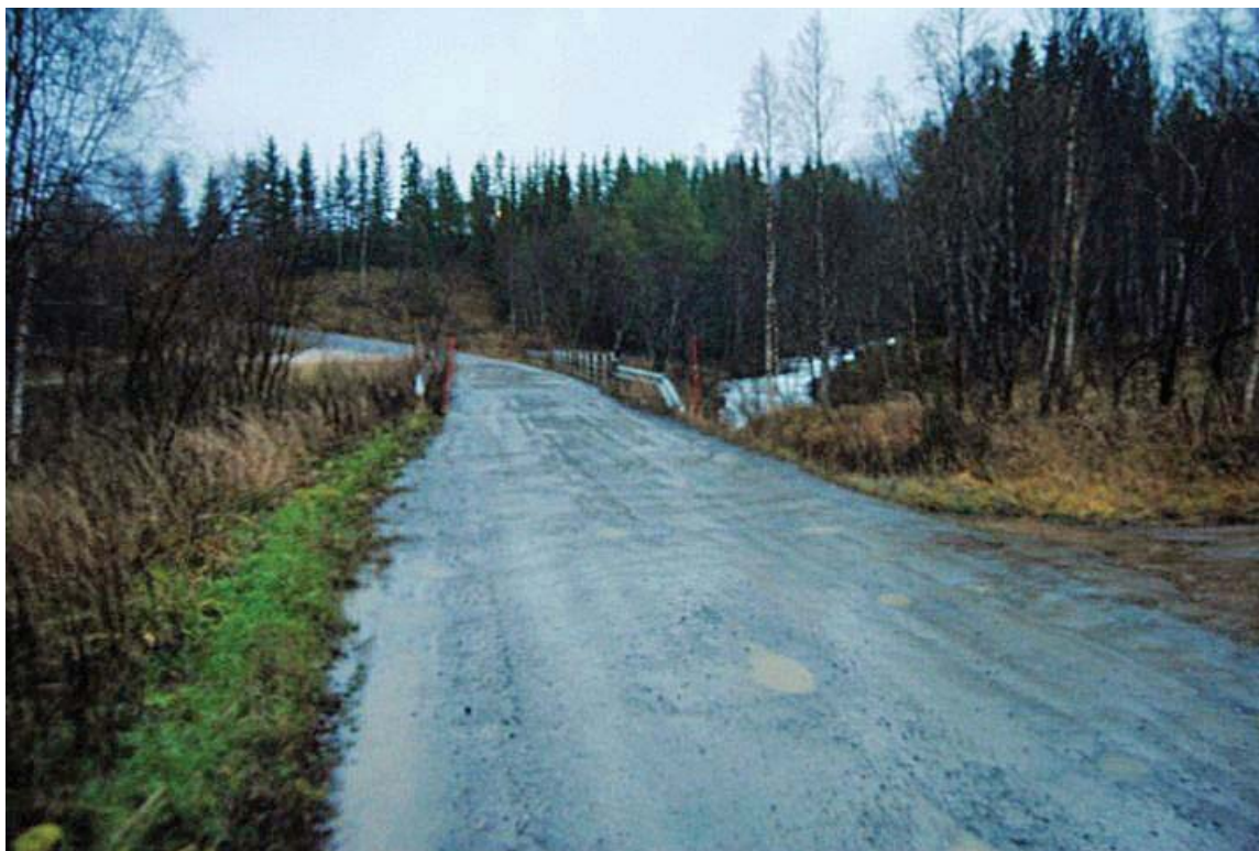
Bro over Middagselva ved ca kote 90 moh i midten av bilde, sett mot øst. Begynnelsen på skogsveien vises til høyre i bilde.
