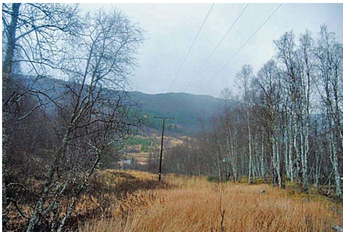
Linjetrasé på vestligside av Middagselva sett mot nordvest fra ca kote 55 moh.
