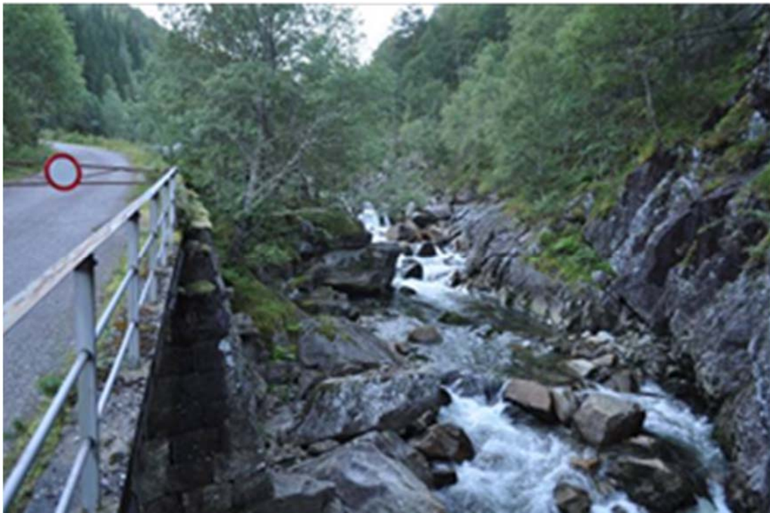
Bildet som viser område for plassering av inntak (bilde tatt fra broen like nedstrøms inntaket) 02 sept 2010 Vannføring: 1000 l/s
