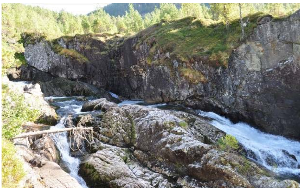
Figur 12: Bergvegg påvirket av fossesprøyt. I bakgrunnen lavvokst, plantet furuskog på sørvestsida av elva
