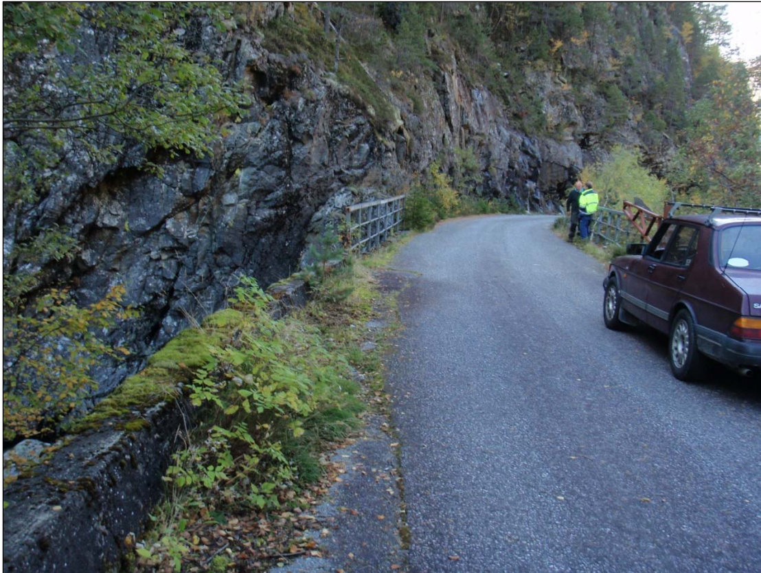
Bilde av broen som krysser elven like nedstrøms inntaket
