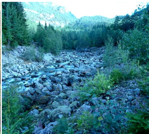
Figur 2.21. Elva ved kraftstasjonsplassen
