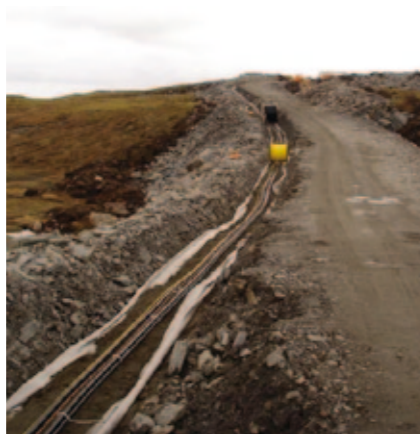
Figur 6. 22 kV-kablene fra hver turbin graves ned i veiskulderen
