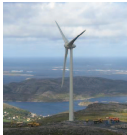
Figur 5. Enercons 2,3 MW turbin installert på Bessakerfjellet
