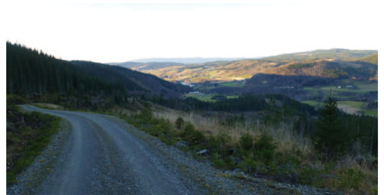
Figur 2. Bilde viser eksisterende skogsbilvei tatt mot Stokkan
