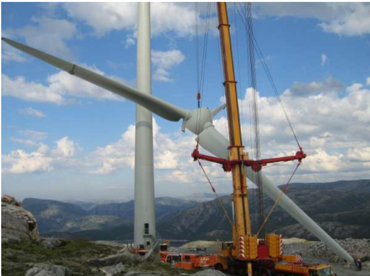
Figur 12 Løfting av nav med vinger (Bessakerfjellet).
