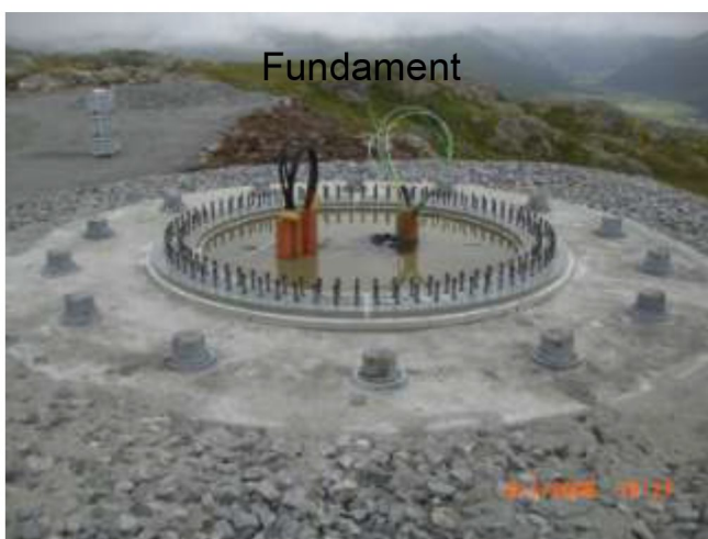
Figur 11 Ferdig støpt og omfylt betongfundament.
