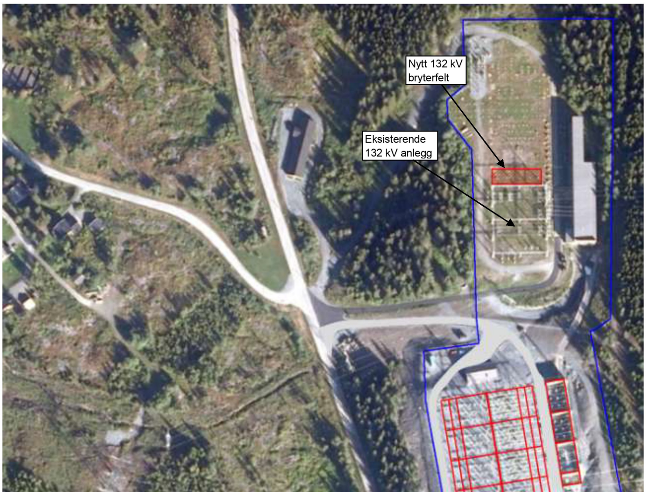
Figur 8. 132 kV anlegget i Nea trafostasjon. 420 kV anlegget kan ses nederst til høyre i bildet. Nytt 132 kV bryterfelt er merket med rød skravur nord for eksisterende 132 kV anlegg
