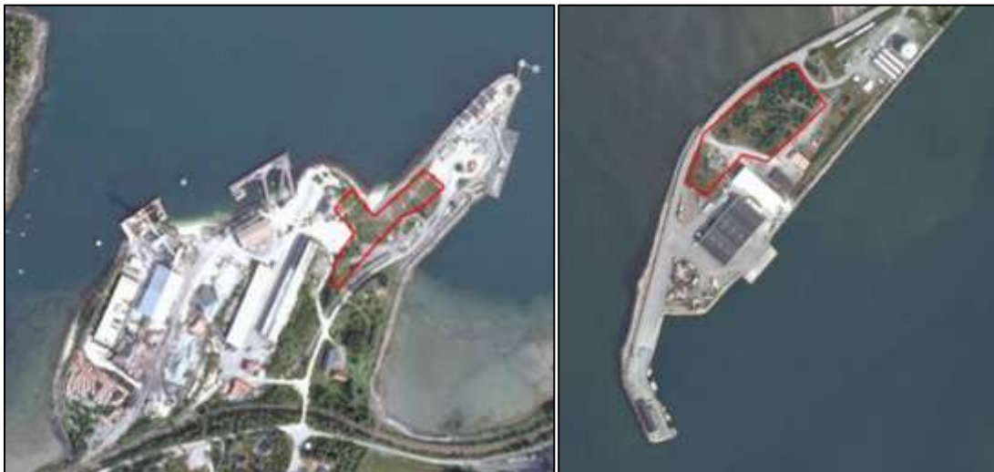
Figur 8 Kaianlegg ved Muruvik til venstre, anlegg ved Stjørdal til høyre.
