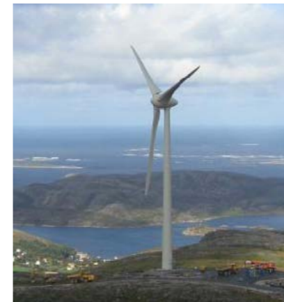
Figur 6. Enercons 2,3 MW turbin installert på Bessakerfjellet
