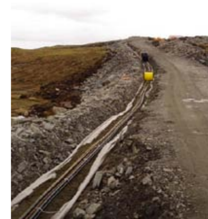
Figur 7. 22 kV-kablene fra hver turbin graves ned i veiskulderen
