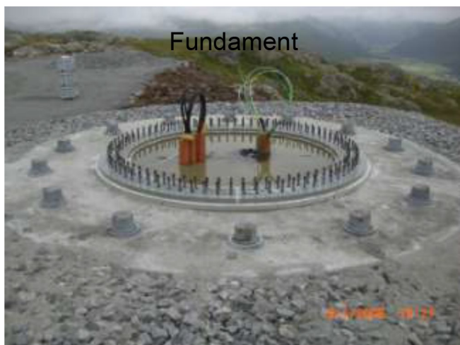
Figur 10 Fundament fra Bessakerfjellet vindkraftverk.
