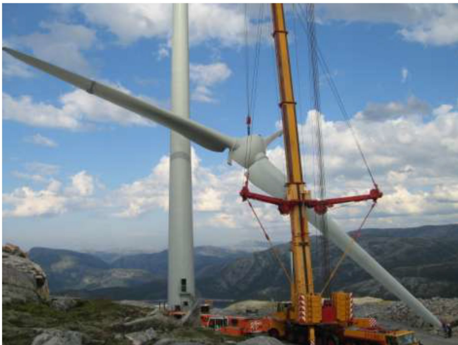
Figur 11 Løfting av nav med vinger på Bessakerfjellet vindkraftverk.
