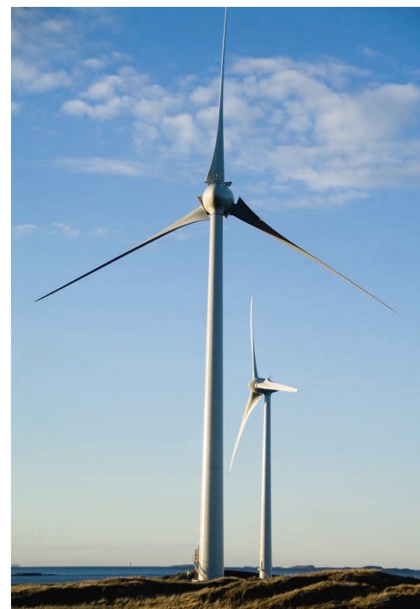
Figur 1 : 2,3 MW-turbiner fra Enercon i Valsneset vindkraftverk (TEK)
