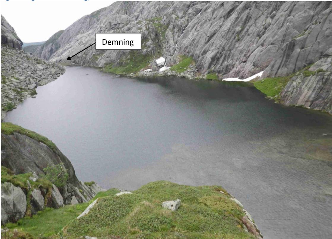
Figur 2: Fagerdalsvatnet med heva vasstand etter bygging av demning.
